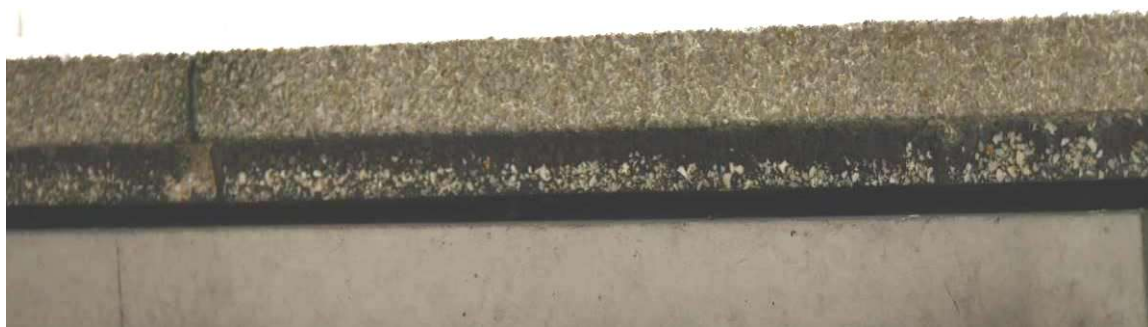
Vervolg figuur 6. Beeld van de onderzijde van een gevelplaat in het plangebied van Lozerhof te Den Haag.
