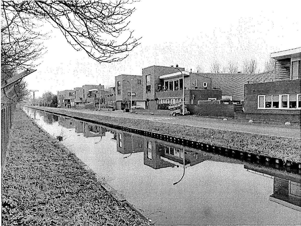
Bebouwing Henricuskade tegenover bouwvlak
