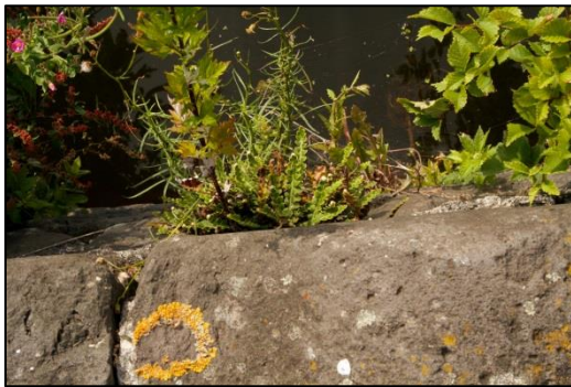
Afbeelding 6: Schubvaren op kademuur
