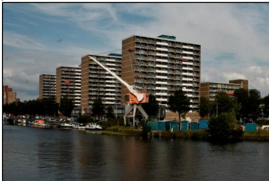
Afbeelding 4: Eén van de kranen aan de laakhaven
