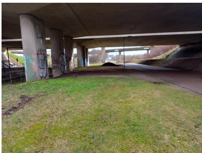
Figuur 2.2a: gebied waarbinnen de verlegging gaat plaatsvinden, kijkend richting het oosten
