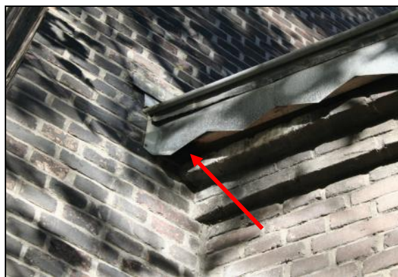
Afbeelding 7: Openingen bij dakranden
