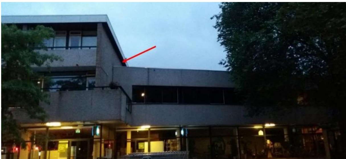
Afbeelding 7. Locatie invliegende gewone dwergvleermuis dat duidt op een verblijfplaats.
