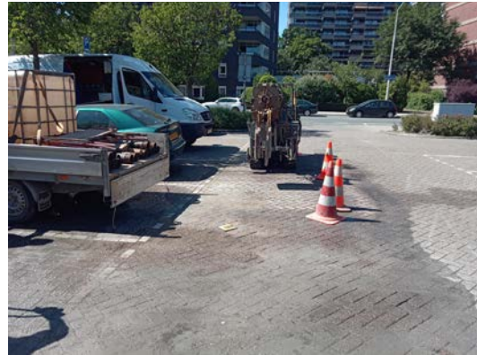
20. Na plaatsing straatpot
