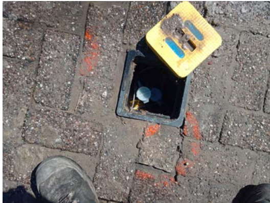
19. B-04 plaatsing Peilbuis + straatpot
