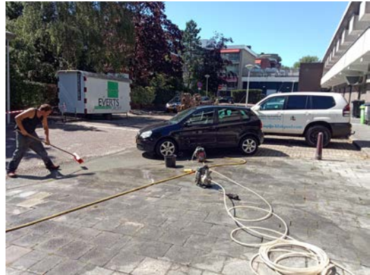
26. Na plaatsing straatpot
