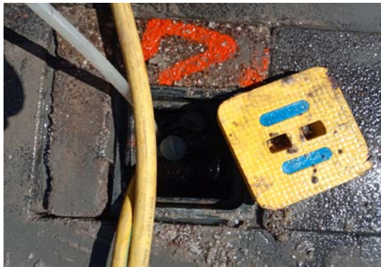
27. Plaatsing peilbuis en straatpot
