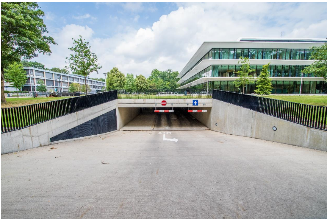
Afbeelding 5.4 Ondergrondse parkeergarage (bron: Tom Hessels, IFV)
