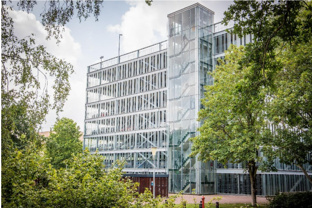
Afbeelding 5.1 Open parkeergarage (bron: Tom Hessels, IFV)
