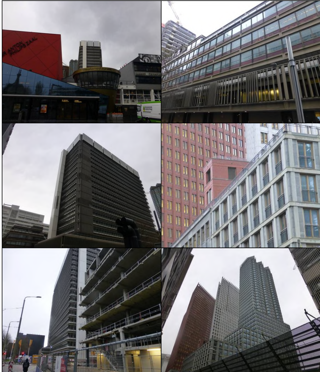
Figuur 5.2. Impressie gebouwen in het plangebied. Linksonder het gebouw waar momenteel sloopwerkzaamheden plaatsvinden en rechtsonder zicht op de nieuwe gebouwen in deelgebied 1. Midden links is het oude, leegstaande gebouw van het Ministerie van Justitie weergegeven.
