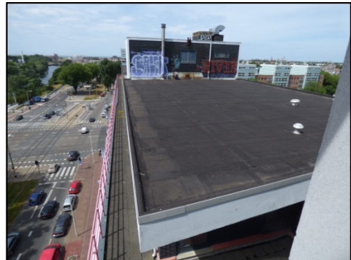
Foto 2: Plat dak zonder grind
