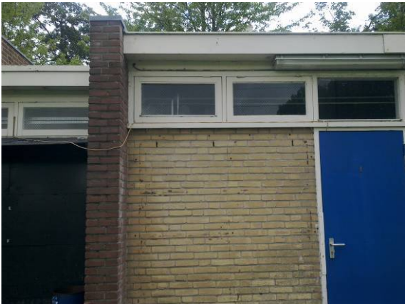
Foto 3: Open stootvoegen op beperkte hoogte; geen kieren tussen daklijst en muur
