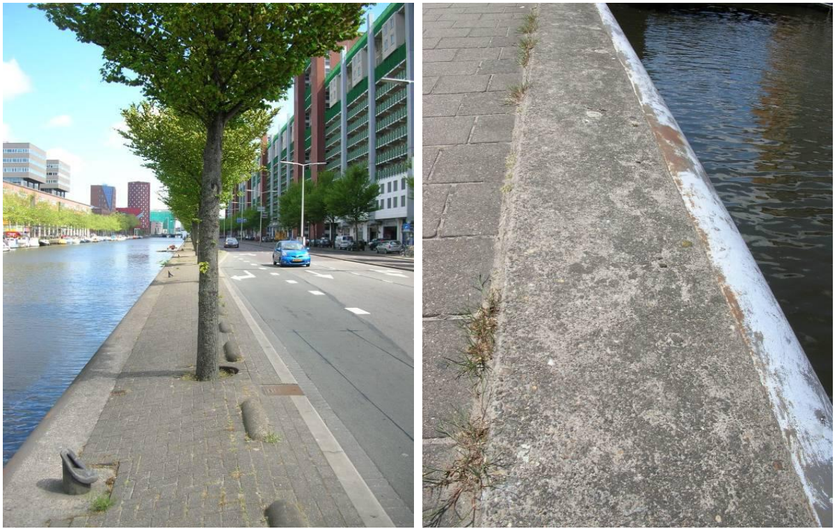
figuur 4.31 de bestaande kade en kaderand
