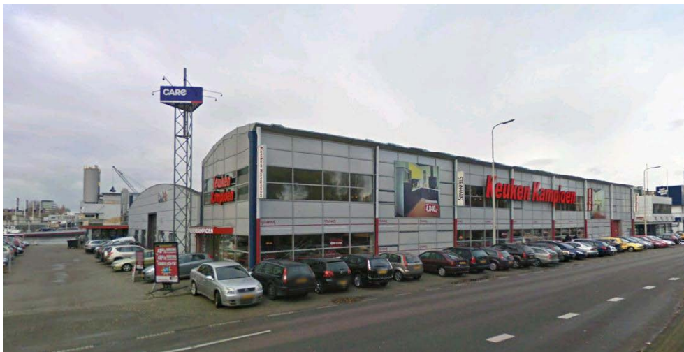
Figuur 1: Aanzicht perceel Beo Vastgoed Warmond B.V. kijkende in noordelijke richting.
