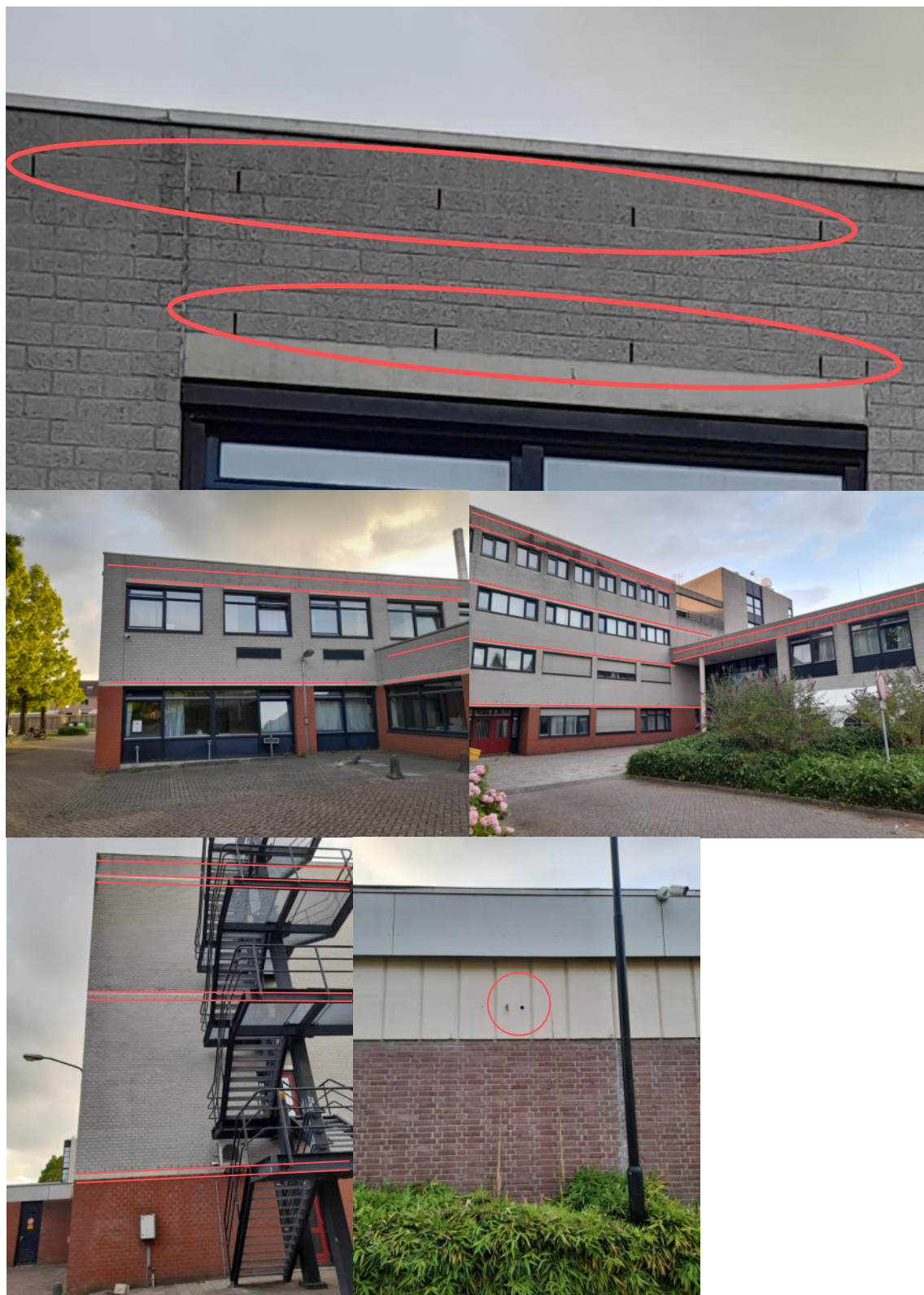
Figuur 2.4: Stootvoegen in kazernegebouw
