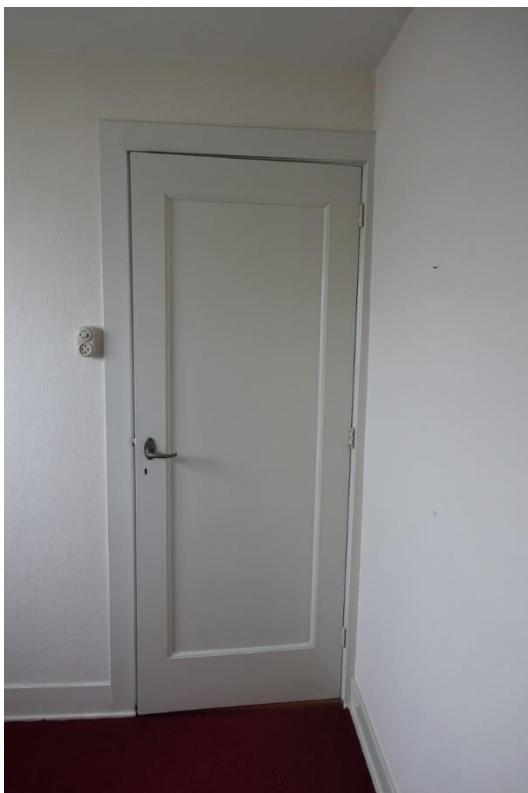
Links één van de deuren van de slaapkamer, alle deuren hebben een gelijke indeling met één vlak paneel. Rechts het beslag van waarschijnlijk nikkel. Dit is overal oorspronkelijk aanwezig. De deur op de foto tussen keuken en hal is vernieuwd, waarschijnlijk om deze brandvertragend te maken. Het oude beslag is hierbij herplaatst.
