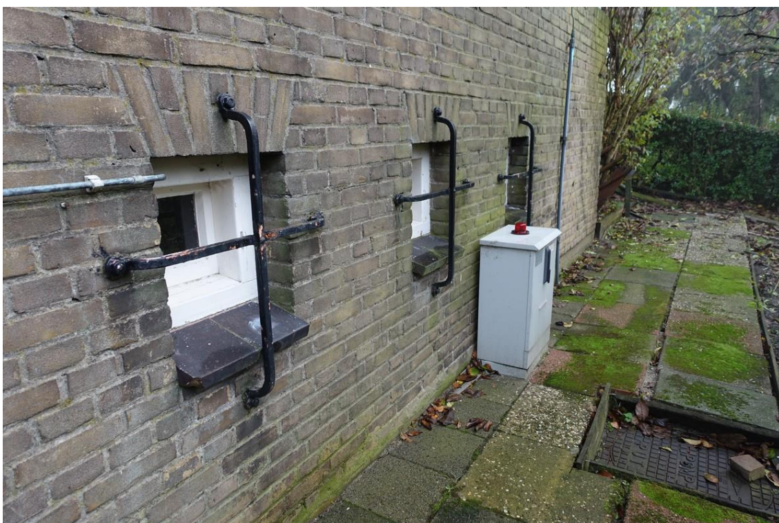
De drie kelderlichten met smeedijzeren diefijzers. De kozijnen zijn ook hier van zwaar formaat. De openingen zijn met de geglazuurde raamdorpels en de strekse bogen zeer karakteristiek.
