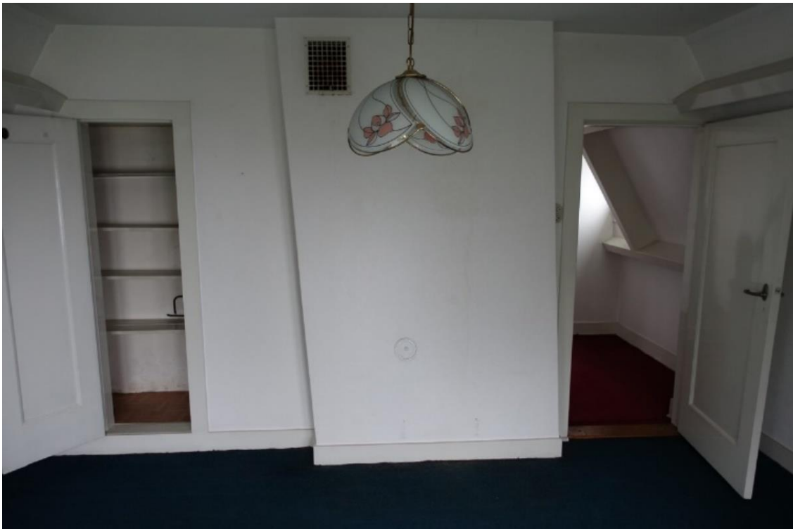
De grote slaapkamer gezien naar de binnenmuur. Links de vaste kast, rechts de doorgang naar de overloop met ertussen de rookkanalen, waarvan er één voor ventilatie wordt gebruikt.
