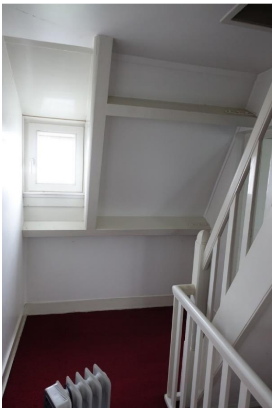
Links de slaper langs de dakkapel in het dakvlak aan de voorzijde. Rechts daarvan de gordingen en de trap. Rechts de slaper in de slaapkamer aan de achterzijde. Onder het dakvlak is een vaste kast geplaatst. Geheel rechts het rookkanaal tegen de binnenmuur.
