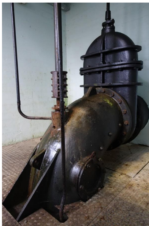
Links één van de poeren met hardstenen blok waarop de ligger van de kraanbaan draagt. De poeren en blokken dateren uit de bouwtijd, de kraanbaan is redelijke recent vernieuwd. Rechts de persleiding met links de aandrijfjas van de pomp naar het schoepenrad en rechts de afsluiter.
