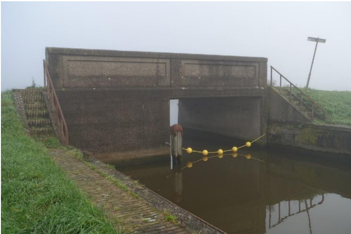
De brug over de sluis is een integraal onderdeel van de betonconstructie van de sluis. Links sluit een betonnen wand de verbrede sluiskom, rechts overspant het brugdek de doorvaaropening naar het kanaal. In de balustrade zijn hier twee spaarvelden opgenomen.
