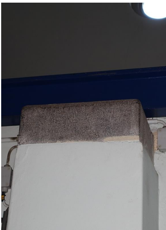
Links één van de poeren met hardstenen blok waarop de ligger van de kraanbaan draagt. De poeren en blokken dateren uit de bouwtijd, de kraanbaan is redelijke recent vernieuwd. Rechts de persleiding met links de aandrijfjas van de pomp naar het schoepenrad en rechts de afsluiter.
