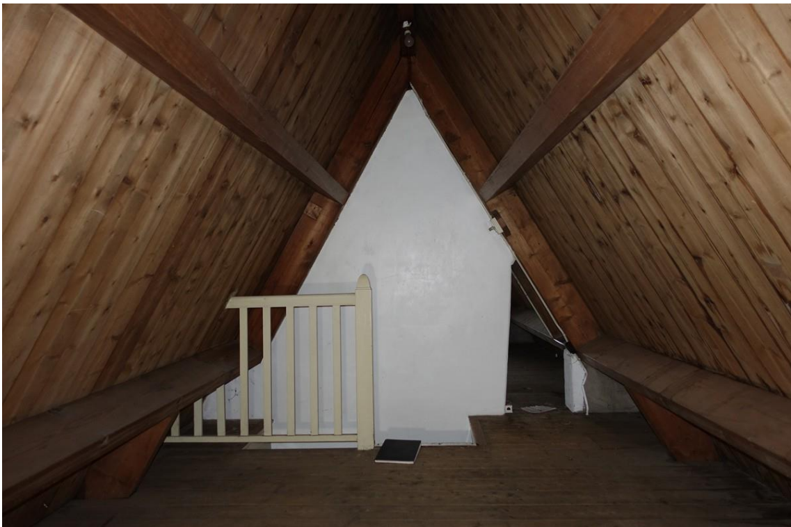
De zolder gezien naar de binnenmuur aan de linkerzijde die keuken en woonkamer scheidt. Daarvoor de trap naar de verdieping. Rechts een kleine doorgang. De draagconstructie is gelijk aan hierboven.
