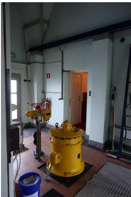
Links op de voorgrond de pomp en erachter de afsluiter. Op de achtergrond de doorgang naar de woning. Rechts de lichte kraanbaan die in de machinekamer is geplaatst om de machines te kunnen plaatsen.
