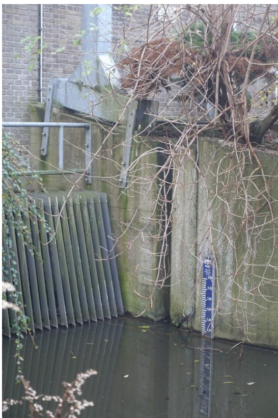
Links de zuidelijke zijde van de maaltocht met de betonnen zijde. Links het krooshek en rechts daarvan de schotbalkspanning en daarnaast een peilschaal. Deze is oorspronkelijk met de naamsvermelding van het Hoogheemraadschap. Rechts de krooshekreiniger gezien naar het noorden.
