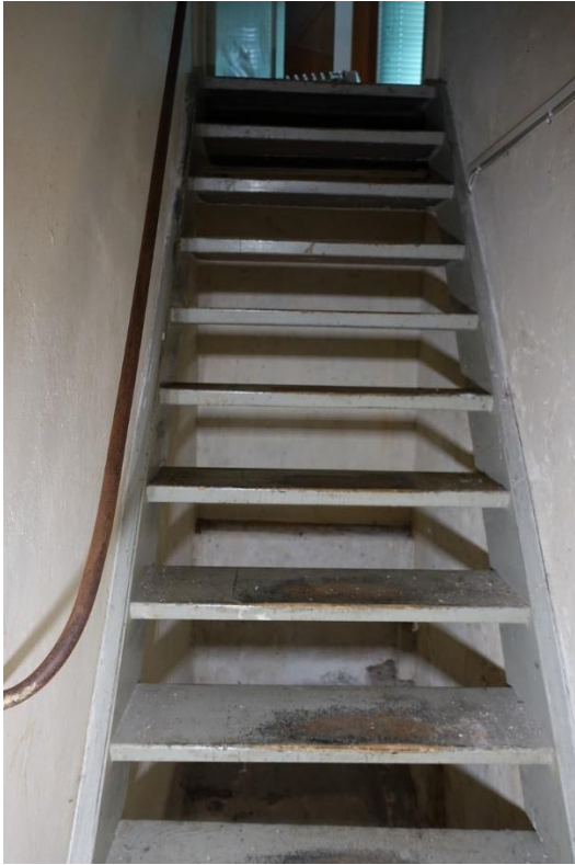
Links de grenen trap in de kelder met aan de linkzijde de ijzeren leuning. Rechts de overloop op de verdieping met traphek en trap naar zowel de zolder als de begane grond.
