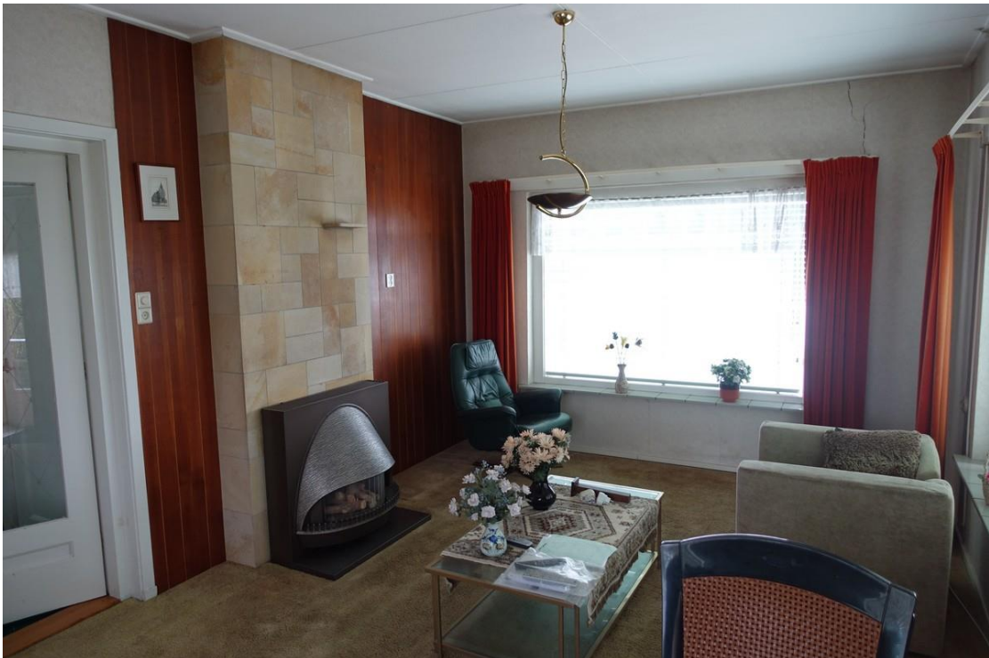
De woonkamer gezien naar de voorgevel met links de gaskachel voor het rookkanaal. Afgezien van de stoffering op de vloer is de afwerking bij de verbouwing in de tweede helft van de 20 ste eeuw aangebracht. De zijde van de buitengevels zijn behangen, de binnenwand is van gelijk eiken fineer als in de keuken voorzien en het plafond is van zachtboard.
