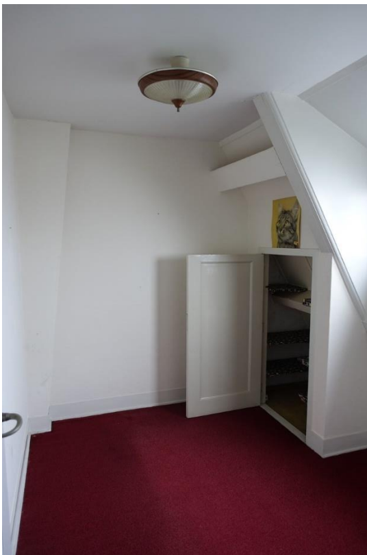
Links de vaste kast in de kleine slaapkamer aan de voorzijde. De kast is ingericht met legplanken. Rechts de dichtgezette doorgang van de hal naar de woonkamer. Gezien de bekleding met eiken finer is dit gelijk met de verbouwing van omstreeks 1975 uitgevoerd.
