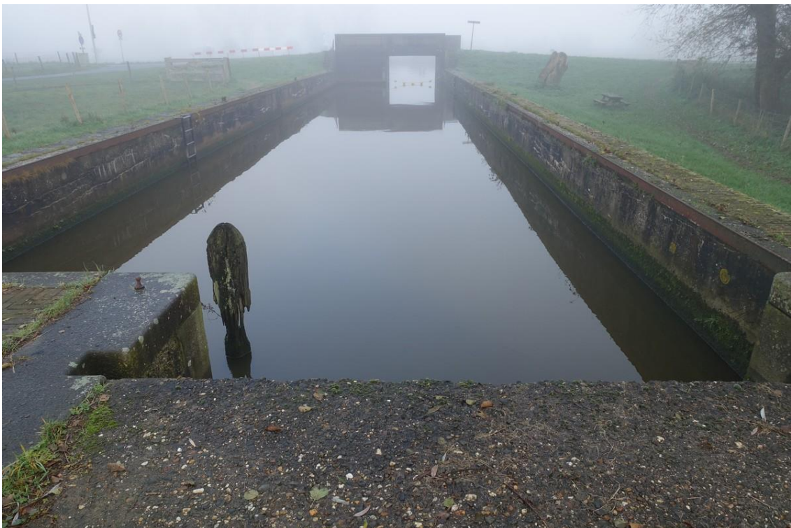
De schutsluis gezien van de overgang van de verbrede kolk aan de zijde van het Gouwekanaal en de schutsluis zelf. De verbreding is waarschijnlijk aangelegd zodat schepen niet in het Gouwekanaal hoefden te wachten wanneer er werd gesluisd. Gezien het drukke verkeer en de kleine schepen uit de polder wilde men dit voorkomen. Aan het einde de brug die de Broekweg over de sluis verbindt.
