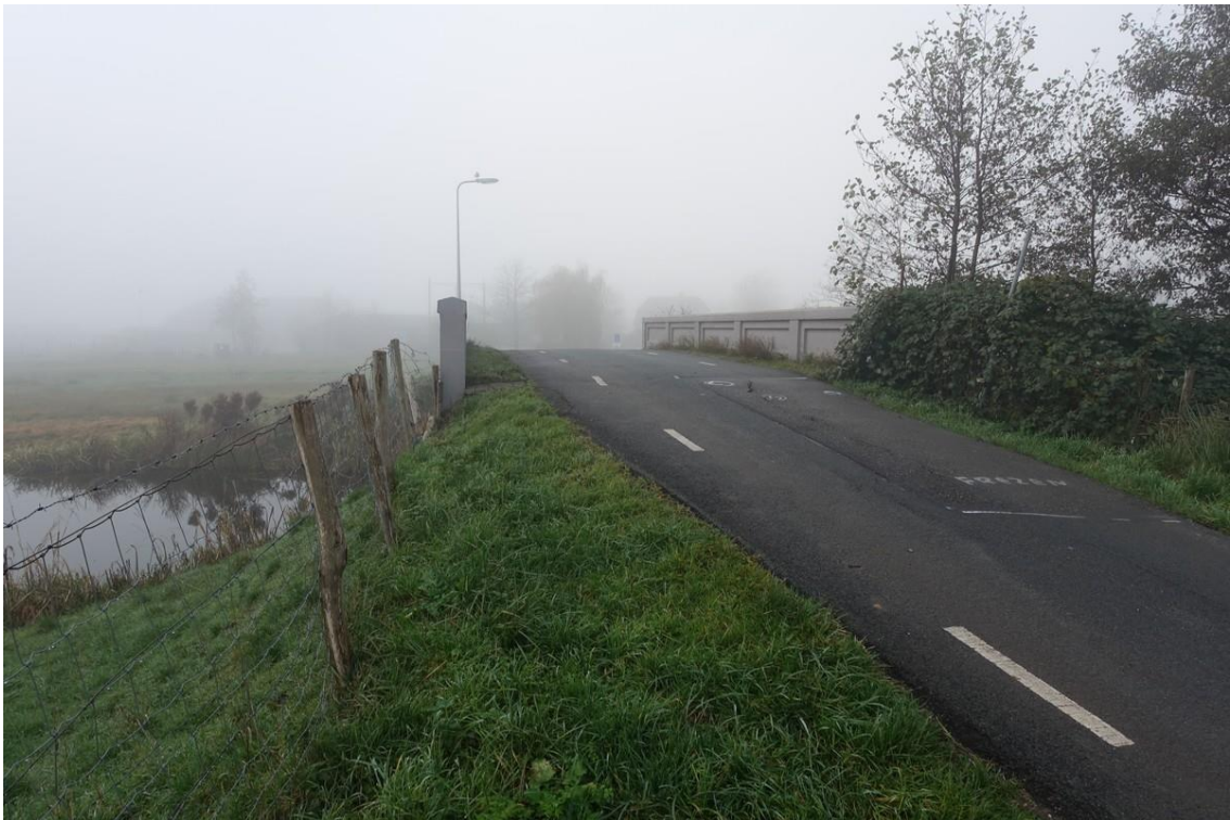
De brug in de Broekweg. Na de brug daalt de weg snel naar het maaiveld van de polder. De brug heeft gestorte balustrades met spaarvelden erin. Deze maken deel uit van de constructie van de brug.
