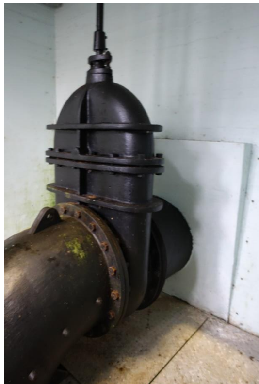
Links de pompkelder met nieuwe gegalvaniseerde trap. De wanden en het plafond zijn van gewapend beton. Boven het water is een vloer van rvs platen gelegd. Rechts de afsluiter in de persleiding. De doorvoer in de kelderwand lijkt nieuw gestort te zijn.
