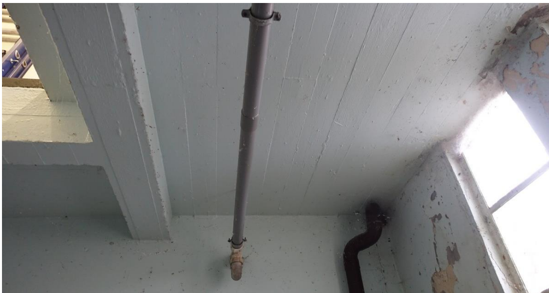
De begane grond vloer van de machinekamer gezien vanuit de pompkelder. De aftekening van de bekisting waarin de beton werd gestort is nog goed zichtbaar. De vloer is verzwaaard met balken om de zware onderdelen van de pomp bij plaatsing en reparatie te kunnen dragen. Rond de opening in de vloer zijn deze balken ook aangebracht.
