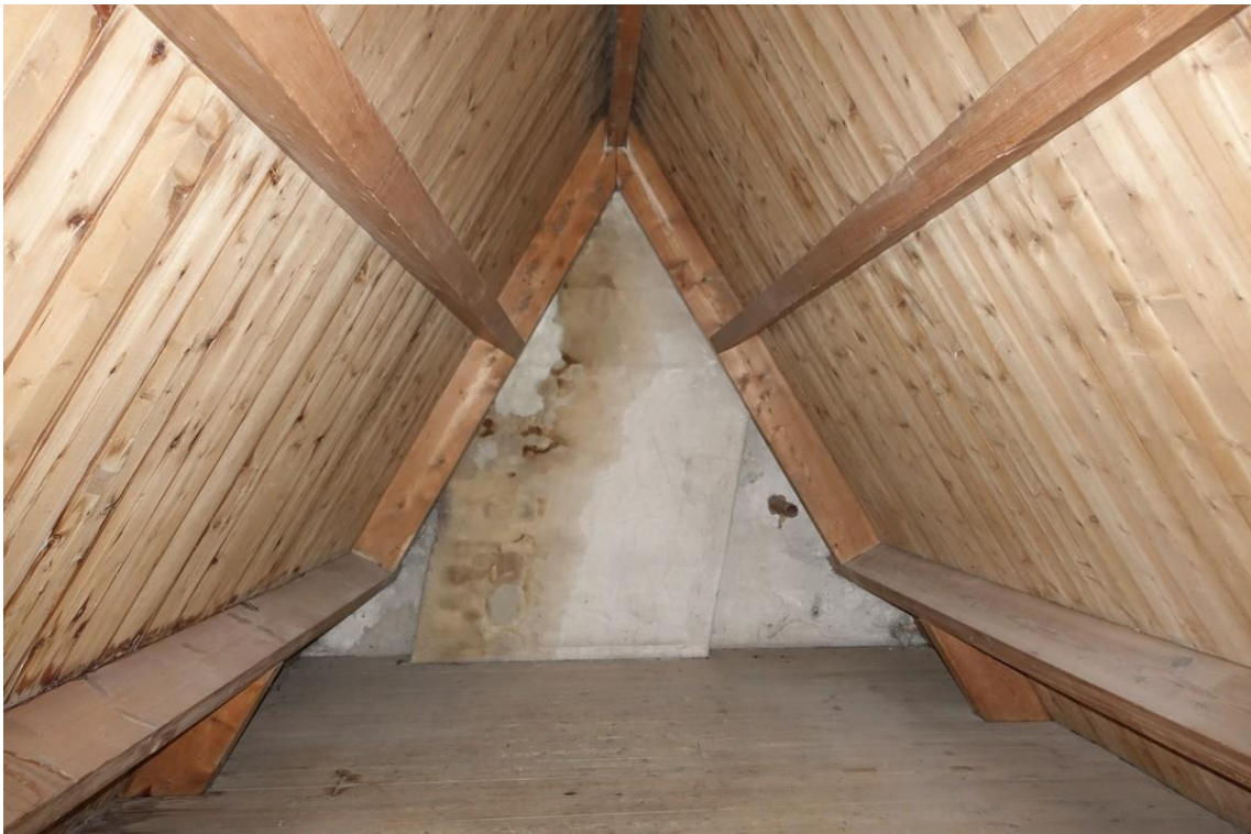
De zolder boven de keuken met de rookkanalen tegen de binnenmuur die de keuken en het gemeaal scheidt. De onderste gordingen liggen in de binnenmuur, daarop staan twee slapers die de bovenste gording en de nokgording dragen. Onder de onderste gording de slapers van de dakkapellen.
