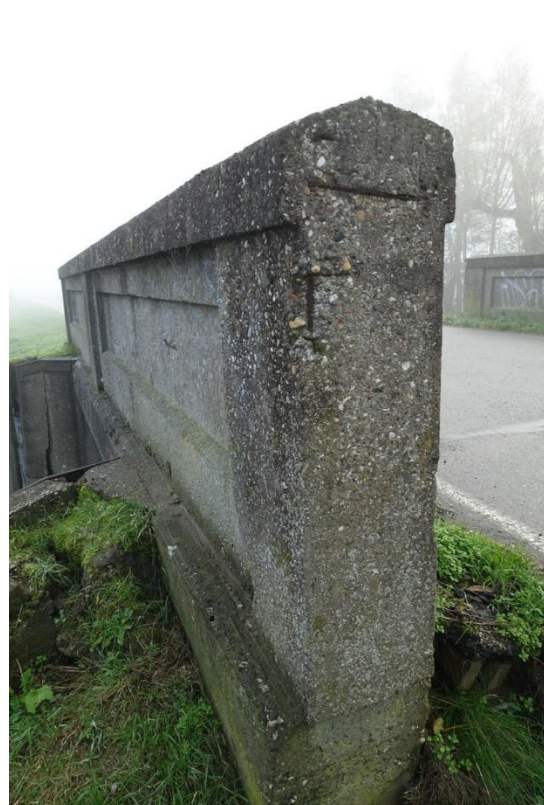
Links de schutsluis vanaf de dam die erin is gelegd, aan het einde is een sluisdeur zichtbaar. Rechts de balustrade van de brug over de sluis met enig betonrot en rechtsonder de klinkers.
