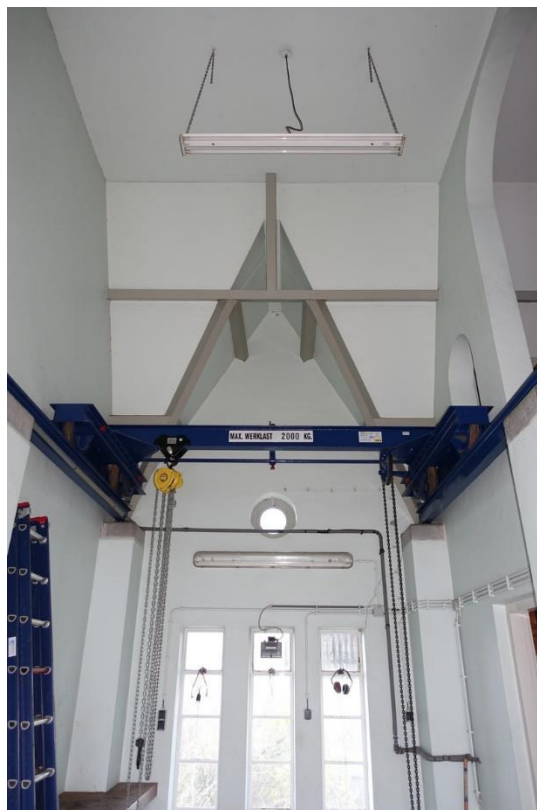
Links op de voorgrond de pomp en erachter de afsluiter. Op de achtergrond de doorgang naar de woning. Rechts de lichte kraanbaan die in de machinekamer is geplaatst om de machines te kunnen plaatsen.
