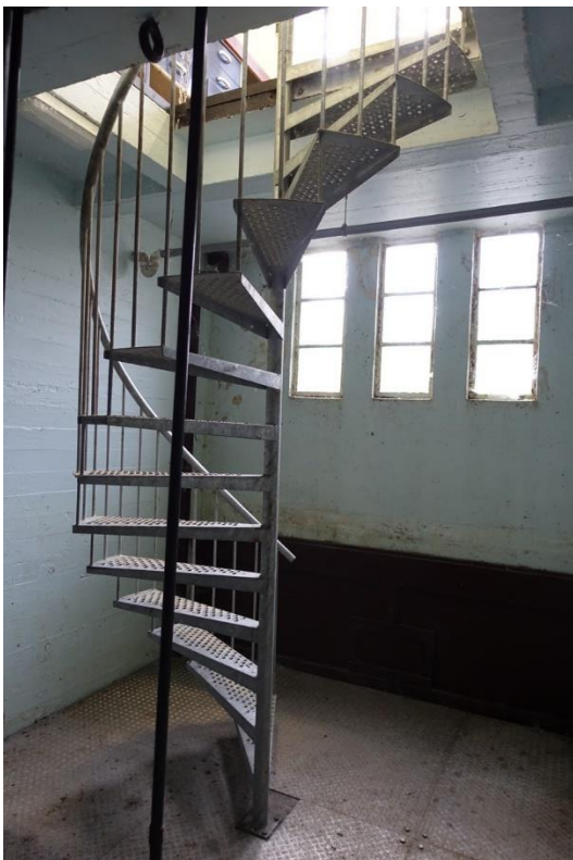
Links de pompkelder met nieuwe gegalvaniseerde trap. De wanden en het plafond zijn van gewapend beton. Boven het water is een vloer van rvs platen gelegd. Rechts de afsluiter in de persleiding. De doorvoer in de kelderwand lijkt nieuw gestort te zijn.
