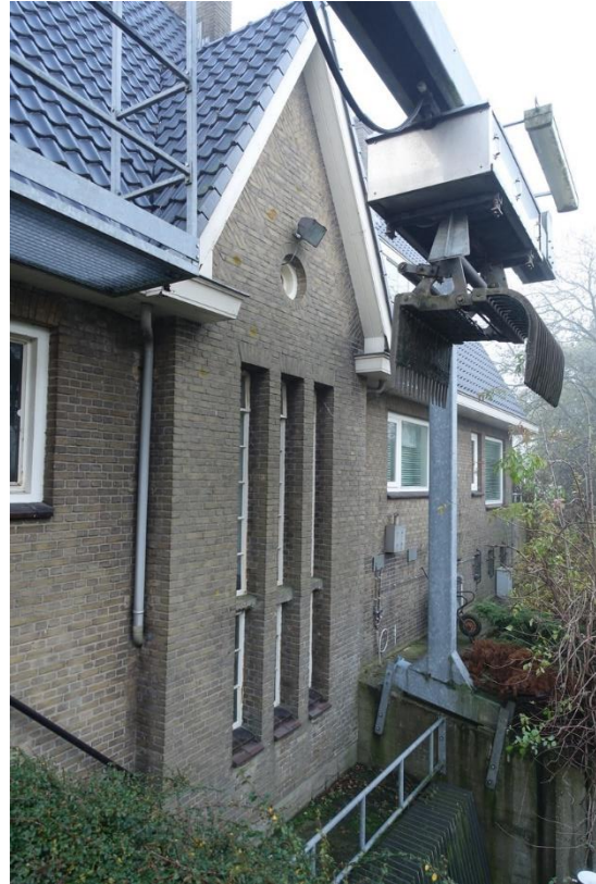
Links de hoek van zijgevel en achtergevel. De achtergevel is hierbij doorgetrokken om de entree op de hoogte van de dijk toegankelijk te maken. In de achtergevel het grote venster dat is ontstaan door de muurdam tussen twee kleinere vensters weg te breken. Rechts de risaliet boven de maaltocht van het gemaal met hierin de drie laddervensters.
