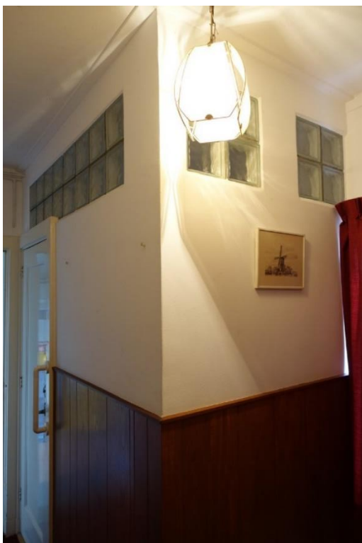
Links de buitenzijde van de douche en het toilet op de begane grond. De glazen bouwstenen zullen voor de daglichttoetreding zijn aangebracht, hoewel zowel de hal als het toilet een venster hebben. Rechts het toilet op de begane grond met de moderne inrichting en afwerkingen.
