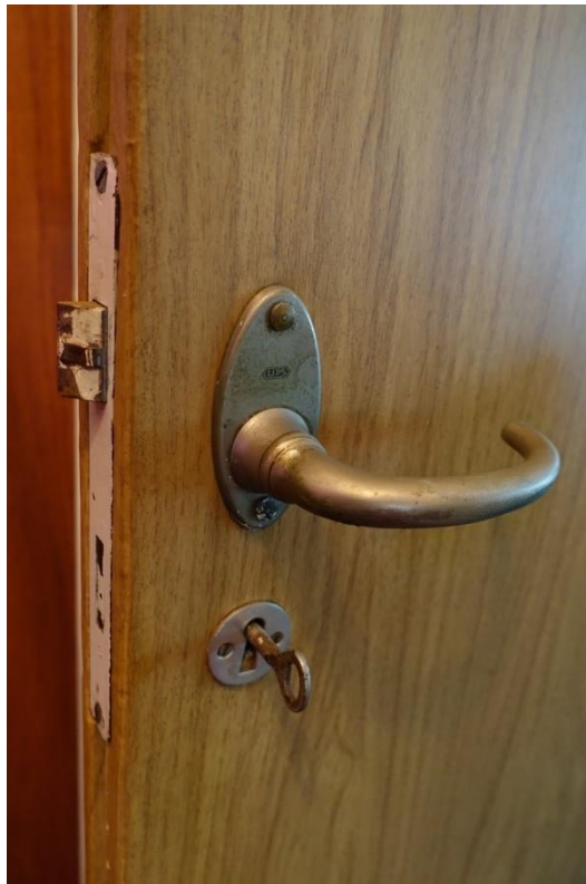
Links één van de deuren van de slaapkamer, alle deuren hebben een gelijke indeling met één vlak paneel. Rechts het beslag van waarschijnlijk nikkel. Dit is overal oorspronkelijk aanwezig. De deur op de foto tussen keuken en hal is vernieuwd, waarschijnlijk om deze brandvertragend te maken. Het oude beslag is hierbij herplaatst.
