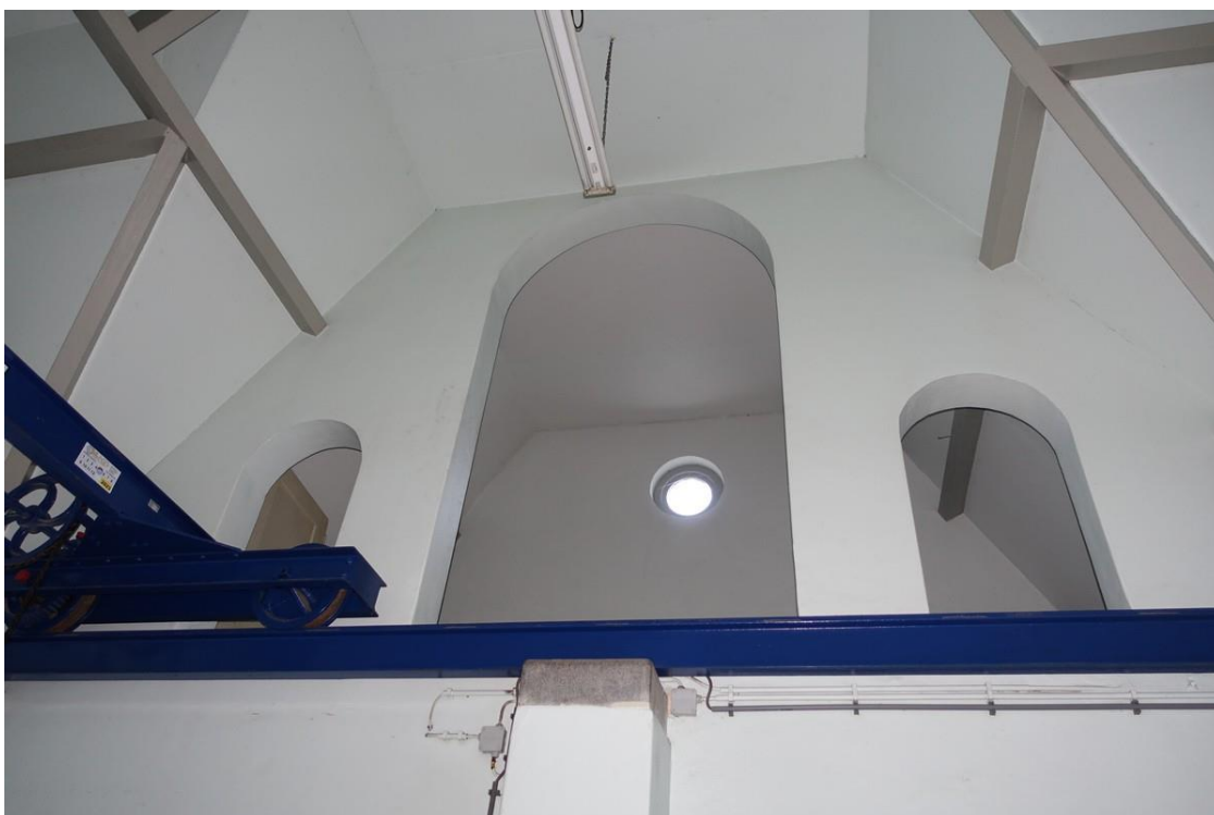
De binnenmuur in het gemaal. Deze heeft men grotendeels open gehouden door er bogen in te plaatsen. Dit kon omdat de wand geen scheidende functie heeft. Het plafond boven de boog is later aangebracht, waarschijnlijk om het klimaat beter beheersbaar te maken.
