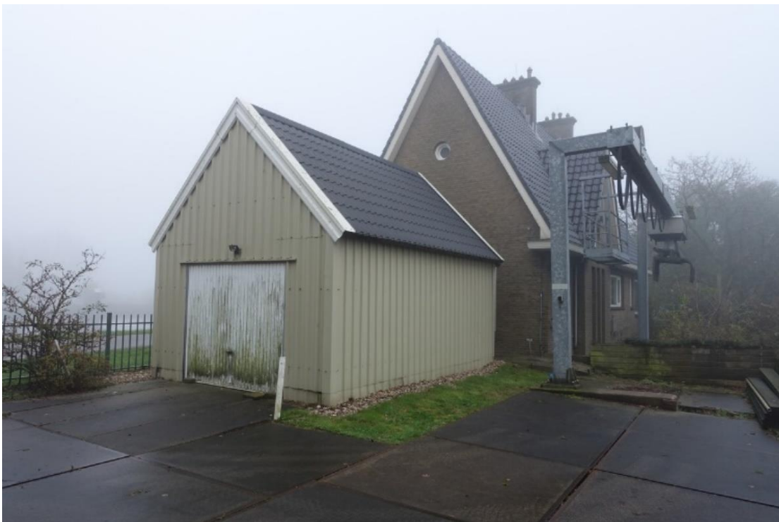
De schuur ten noorden van het gemaal. Het terrein is verhard met stelcon platen die zwaar verkeer naar de krooshekreiniger mogelijk maken.
