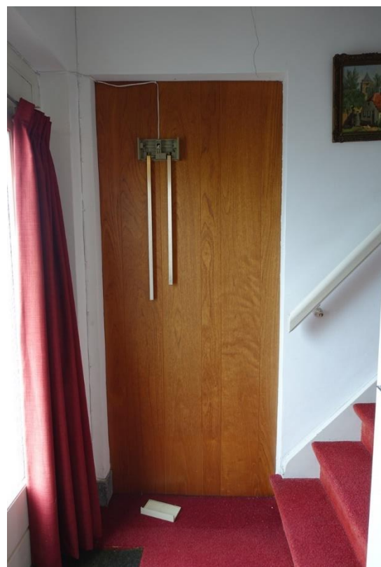
Links de vaste kast in de kleine slaapkamer aan de voorzijde. De kast is ingericht met legplanken. Rechts de dichtgezette doorgang van de hal naar de woonkamer. Gezien de bekleding met eiken finer is dit gelijk met de verbouwing van omstreeks 1975 uitgevoerd.
