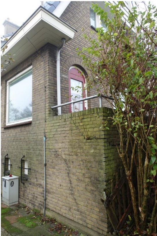
Links de hoek van zijgevel en achtergevel. De achtergevel is hierbij doorgetrokken om de entree op de hoogte van de dijk toegankelijk te maken. In de achtergevel het grote venster dat is ontstaan door de muurdam tussen twee kleinere vensters weg te breken. Rechts de risaliet boven de maaltocht van het gemaal met hierin de drie laddervensters.
