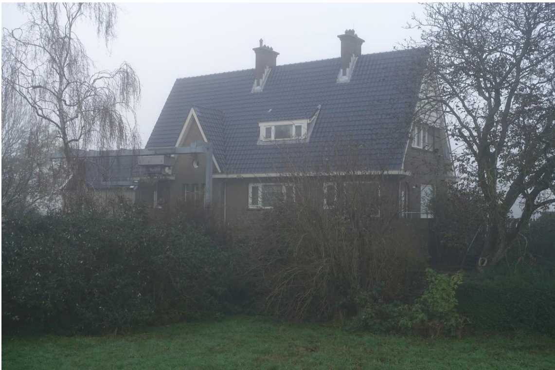
Zicht op de achtergevel van het pand vanaf de Broekweg. De steilte van de kap en de fraai gedetailleerde schoorstenen komen in dit beeld goed naar voren.
