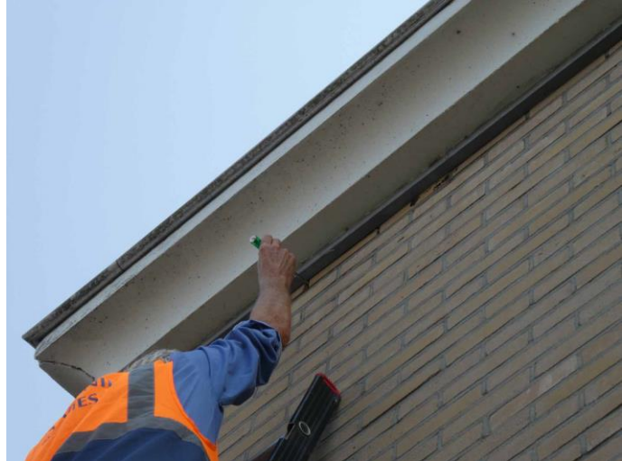
Figuur 10: Inspectie eventuele kieren langs de dakrand. Deze werden niet aangetroffen.
