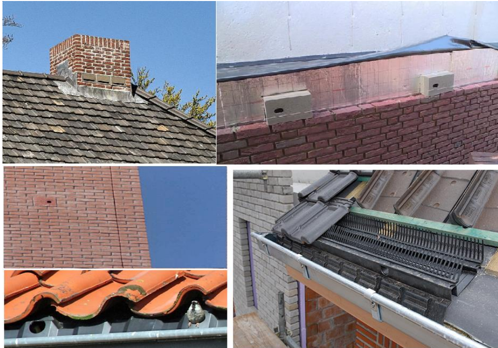
Bovenste foto's: links: ingemetselde vleermuisstenen, rechts: gierzwaluwstenen
