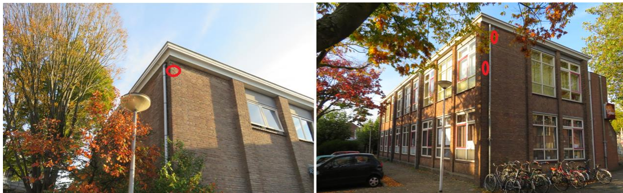
De enige aanwezige open stootvoegen bevinden zich op drie meter van een lichtbron.
