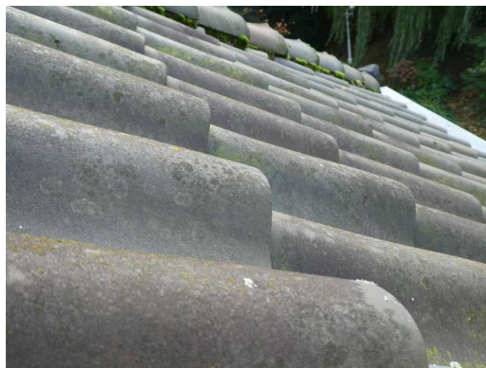
Figuur 18: Close-up dak van de woning
