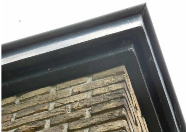
Figuur 17: Afwerking dakrand
