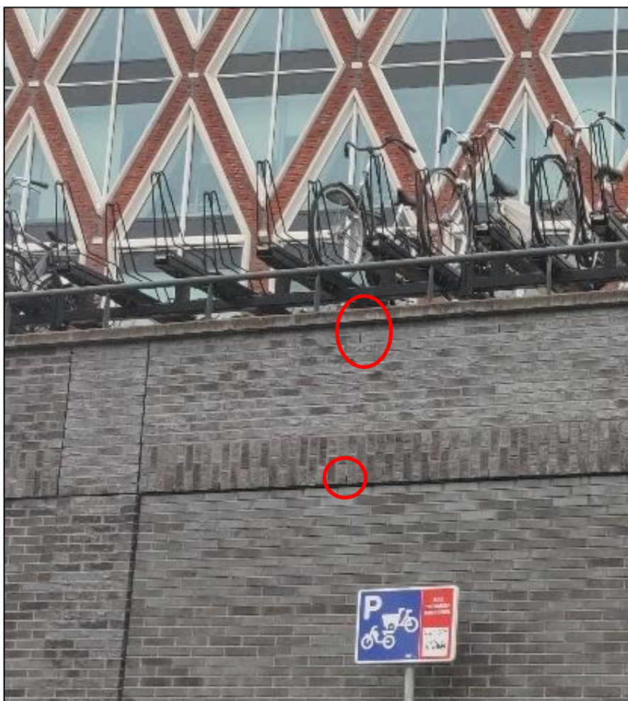
Figuur 7: Open stootvoegen in de gevel van de fietsenstalling
