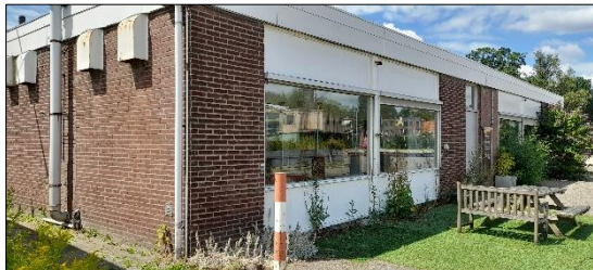
Foto 4: Bebouwing op het plangebied
