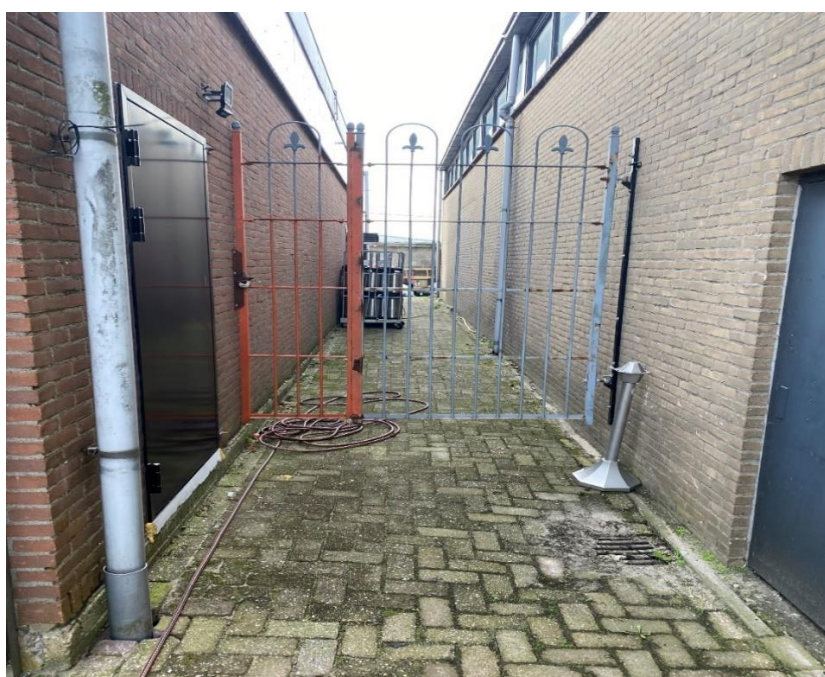
Afbeelding 7 Hekwerk en obstakels in vluchtgang
