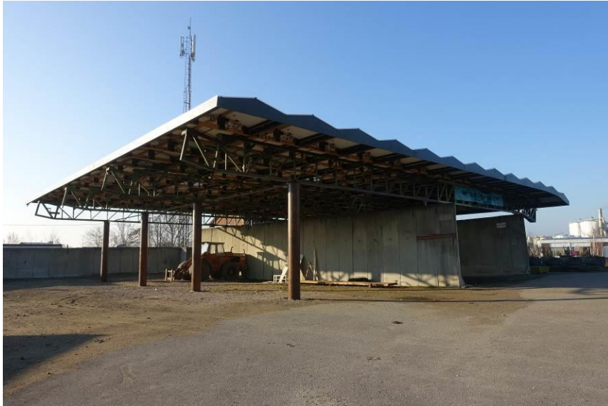
Forse constructie t.b.v. plaatsing van zonnepanelen. (28)
