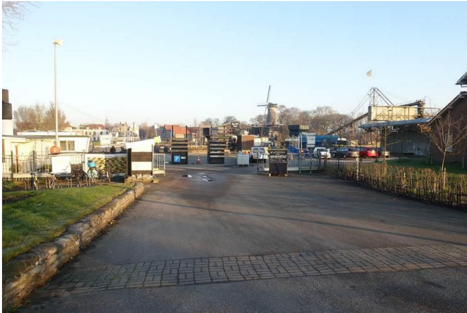
Zicht vanaf de Gouderaksedijk op de terugliggende terreintoegang.
