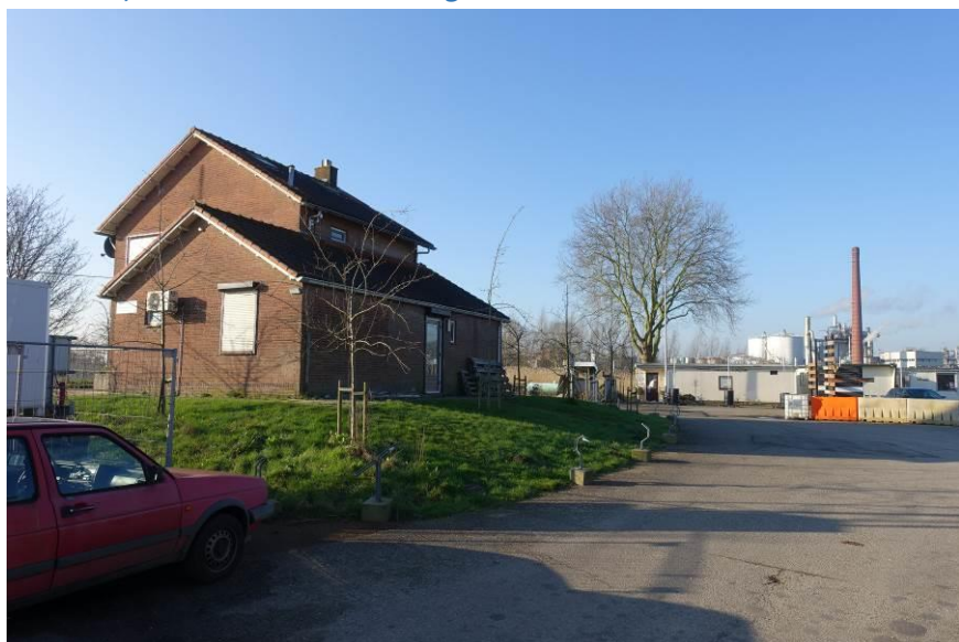
De woning, gezien vanaf het terrein.
