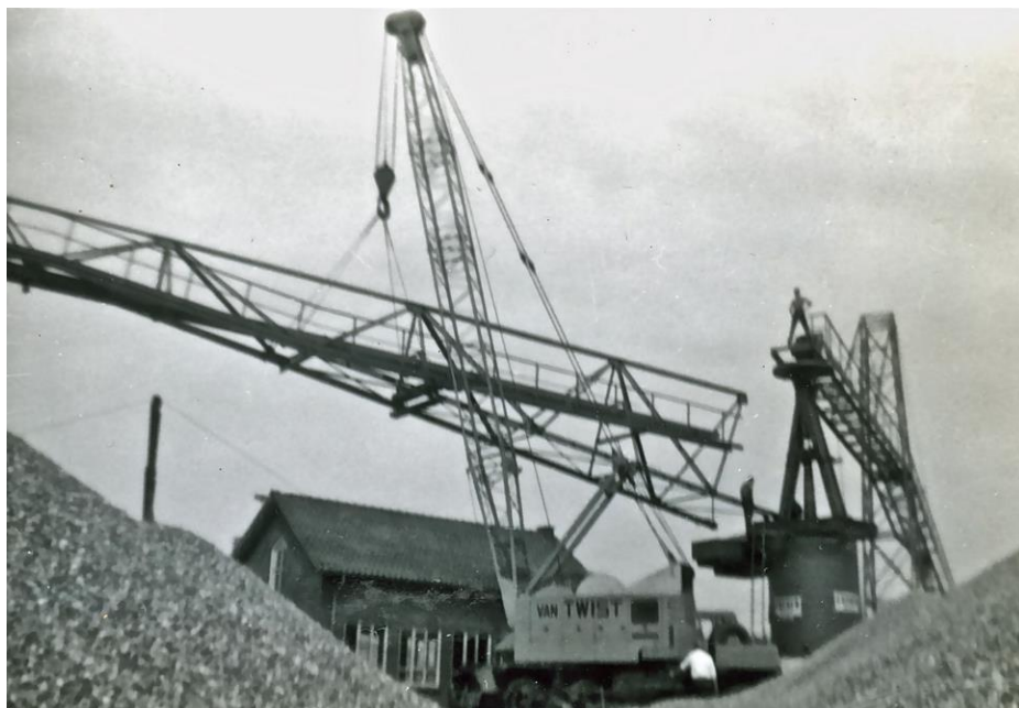
Foto gemaakt tijdens de montage van de zwenkarm en vaste transportband in 1964. Bron: aanlevering door dhr. H. du Pré.
