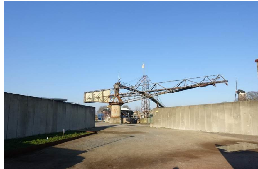
Zeer karakteristiek beeld van de Lange Arm in combinatie met de hier in een straal omheen gesitueerde betonnen keerwanden.
