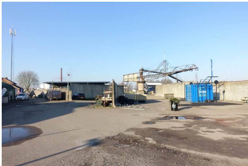
Centraal terreingedeelte gedomineerd door keurmuren en de 'Lange Arm'.
