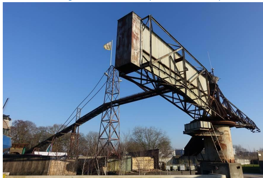
Zicht op de windvaan en de transportband.
