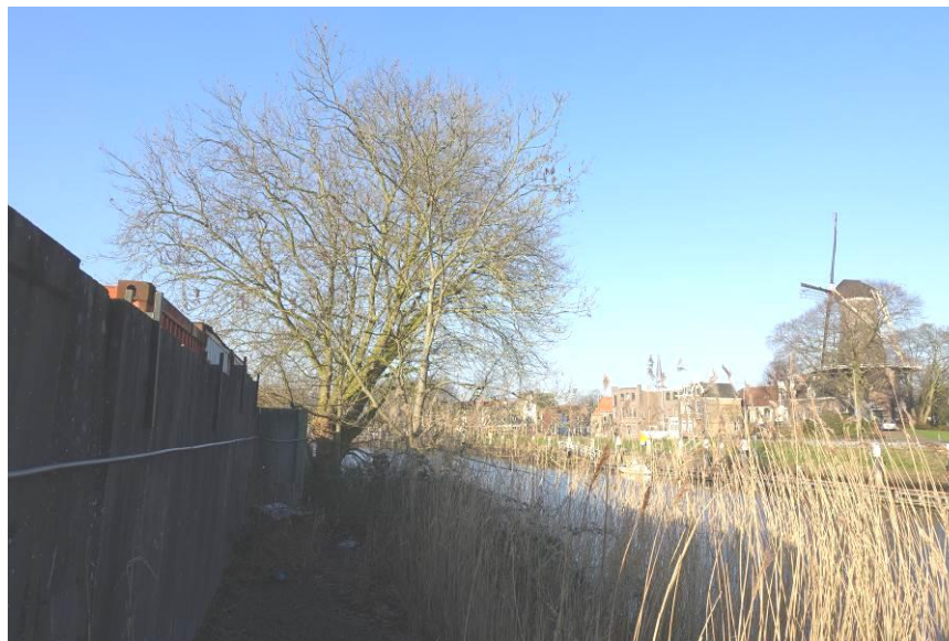
Groene strook langs de buitenzijde van de betonnen keermuur.
