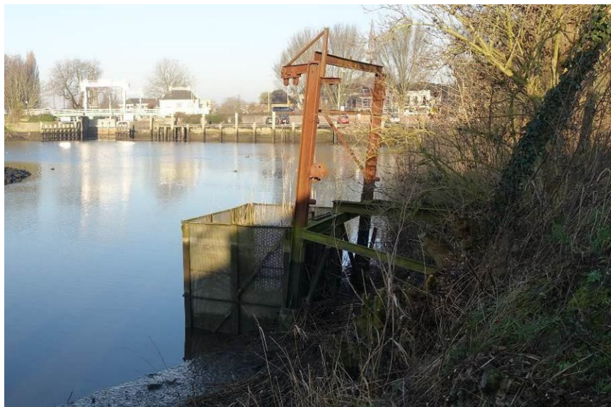
Restanten steiger met takelmechanisme en geperforeerde metalen bak (25).
