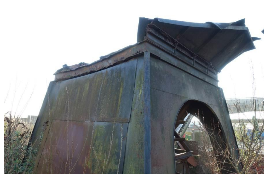
Detail van de oude trechter, waarvan de onderbouw deels is dichtgemaakt.
