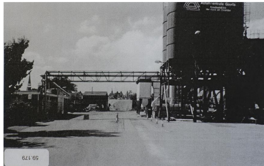
Zicht over het terrein vanaf de toegang in noordelijke richting, met rechts de vernieuwde asfaltinstallatie. Bron: SAM, nr. 59.179.
