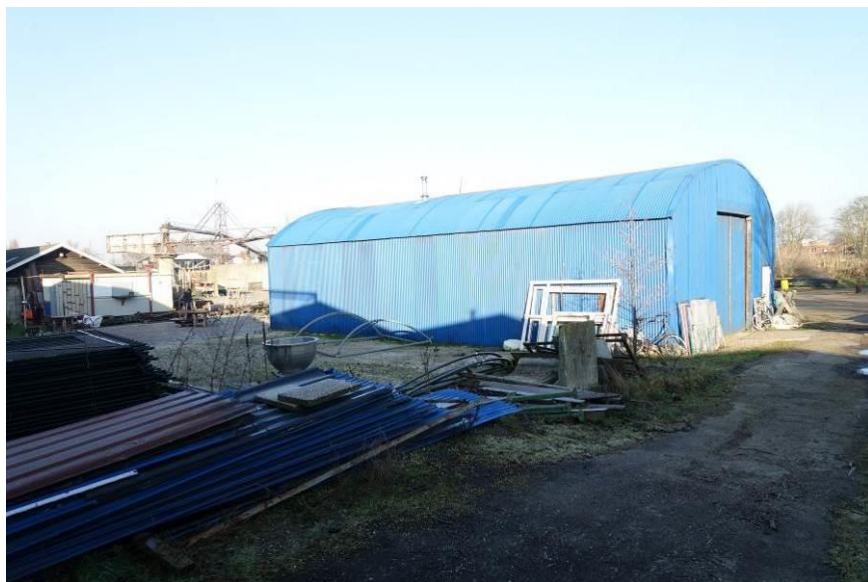
Op het terrein herplaatste golfplatenloods. (22)
