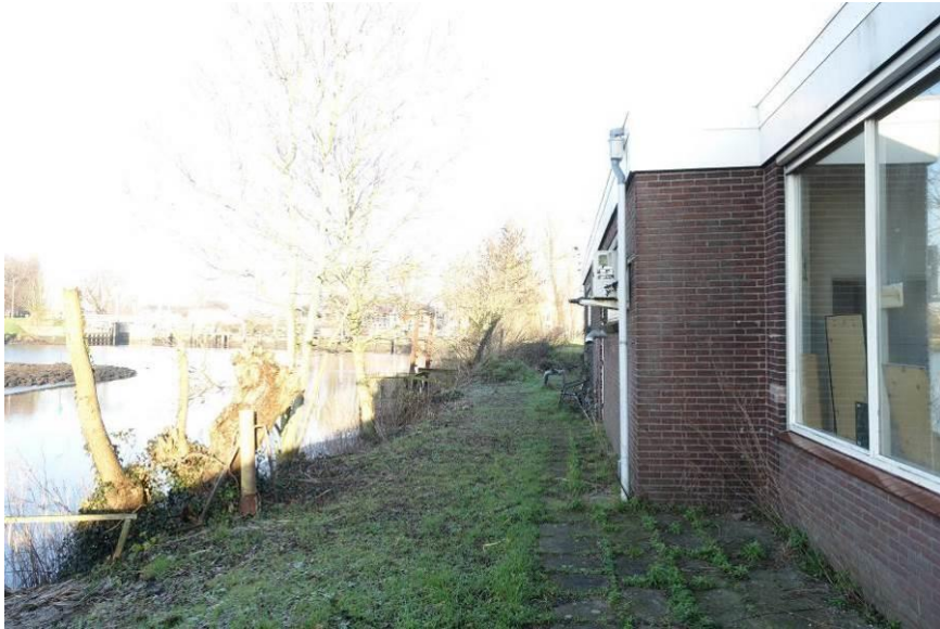
Zicht langs de westzijde van het laboratorium.
