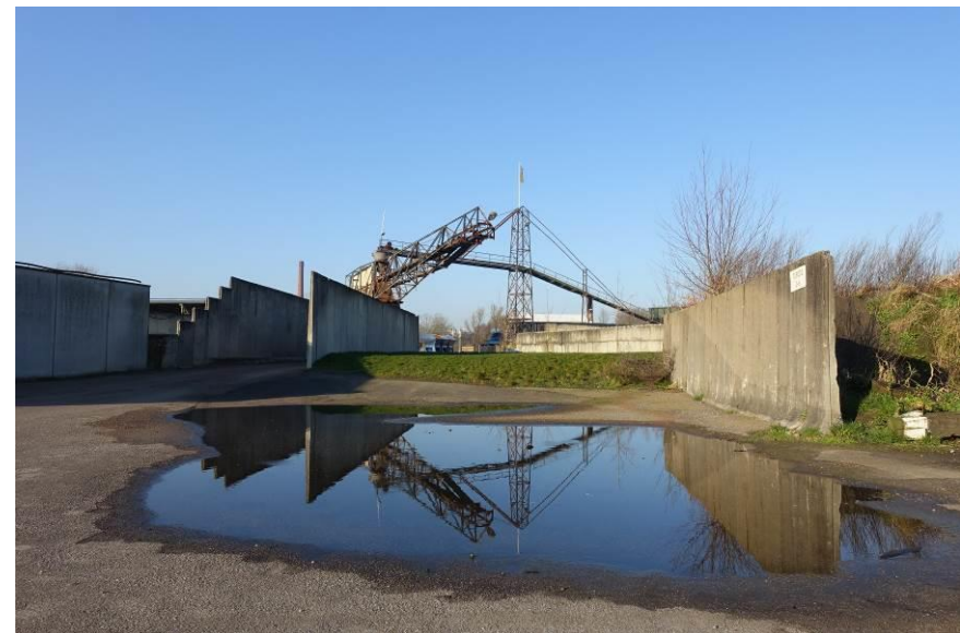
De keerwanden bepalen in hoge mate de structuur van het terrein.
