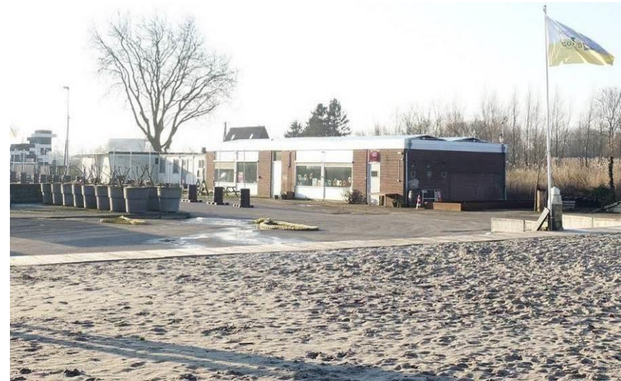
Overzicht van het laboratorium uit het noordoosten.
