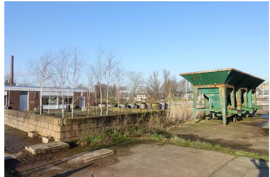
Funderingen en onderbouwen van asfaltinstallatie, deels als terreinstructuur opnieuw ingevuld met beplanting.
