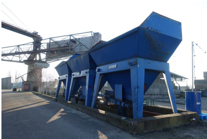
Jongere trechterreeks tussen de 'Lange Arm' en de vroegere asfaltinstallatie.
