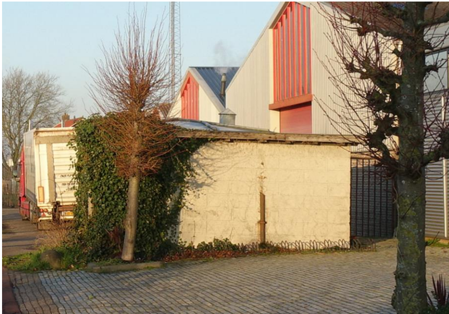
Oostelijk zij aanzicht transformatorhuisje.
