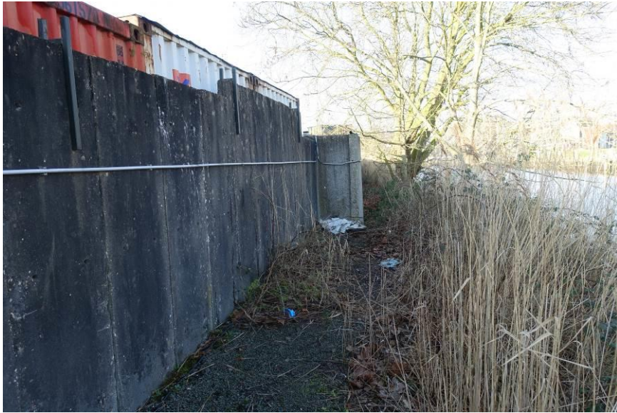
Deels lang de Hollandsche IJssel aanwezige keerwanden.
