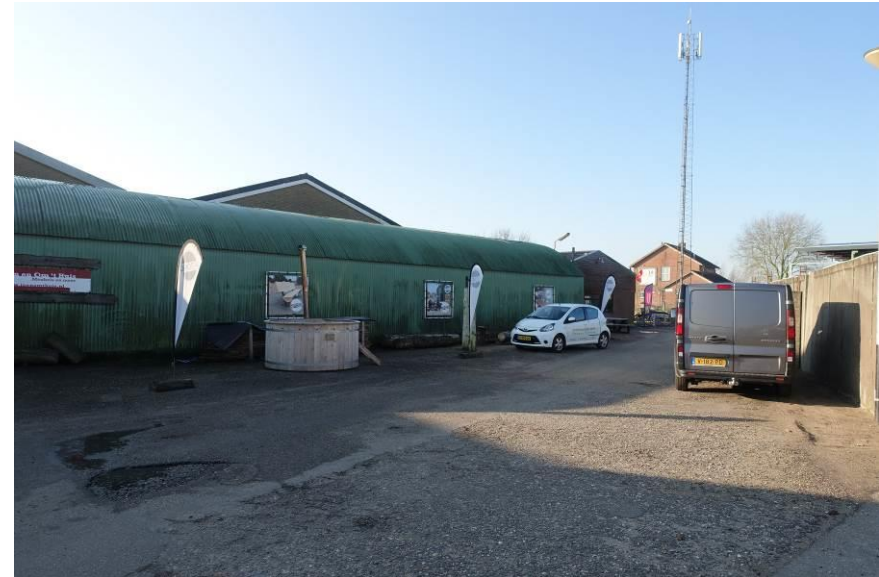
Op het terrein, direct achter de bedrijven aan de Gouderaksedijk herplaatste golfplatenloods. (15)
