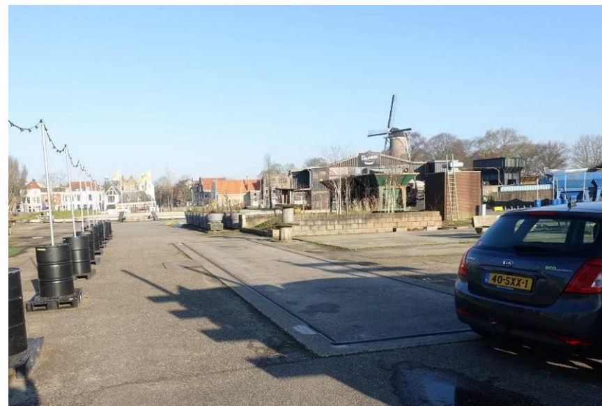
Overzicht van de betonnen weegbrug.
