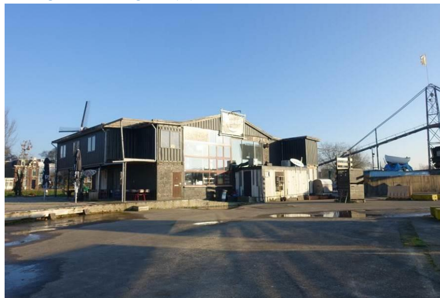
Tweelaags, uit stalen containers opgebouwd gebouw aan de noordrand van het terrein. (24)
