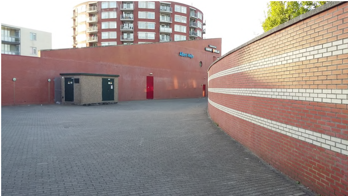
Foto 6: Overzicht laad- en loszone vanaf zuidwest kant achter AH
