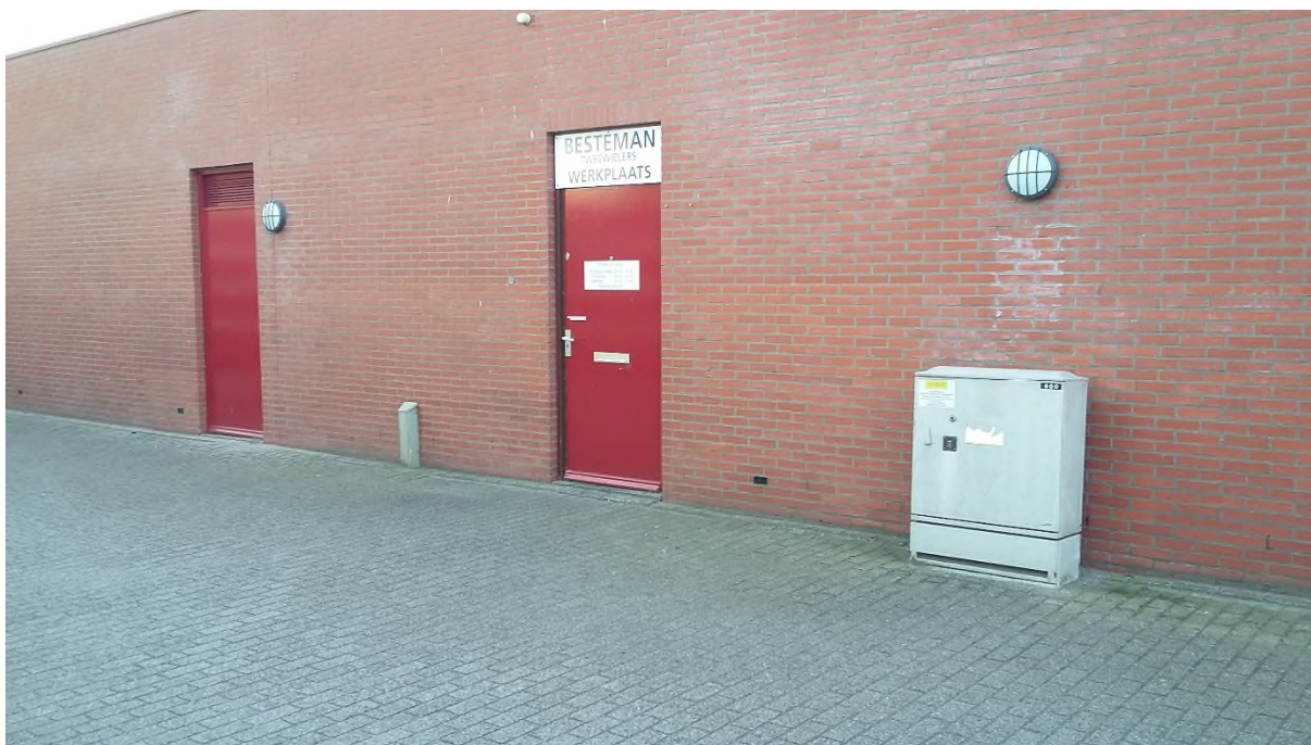
Foto 5: Deur naar werkplaats fietsenmaker en elektriciteitskast
