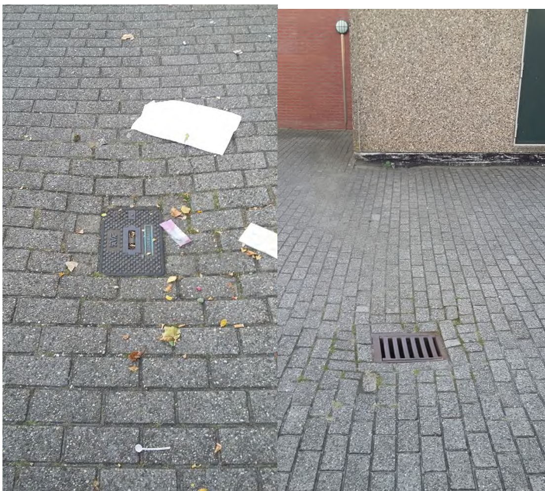
Foto 2 en 3: Brandkraan (links); Water afvoerput (rechts)
