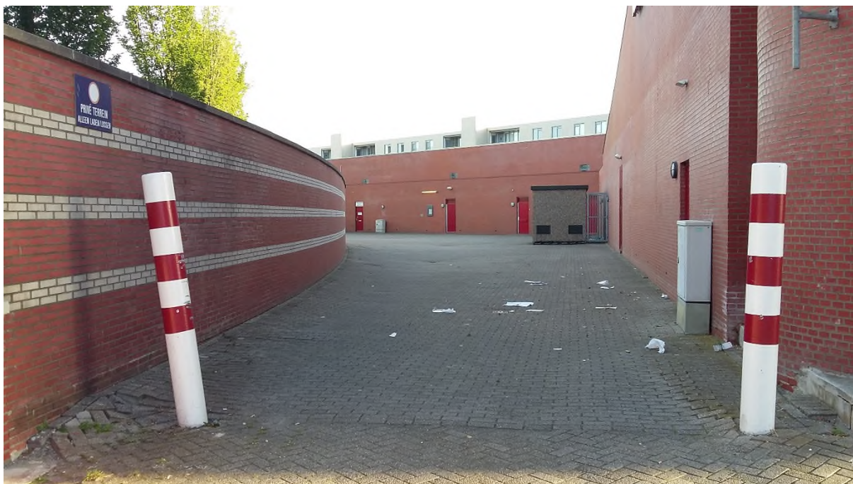
Foto 1: Overzicht laad- en loszone vanaf noordkant achterzijde AH
