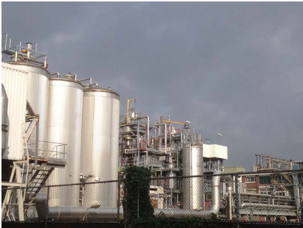
Figuur 2.2: Croda binnendijks, ter hoogte van de leidingbrug over de Rotterdamseweg
