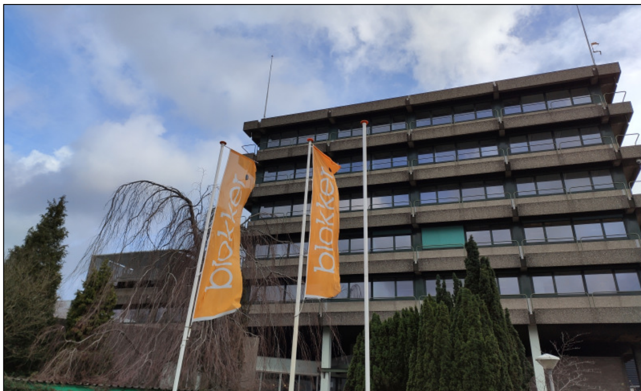
Figuur 3. Hoogbouw met kantoren.
