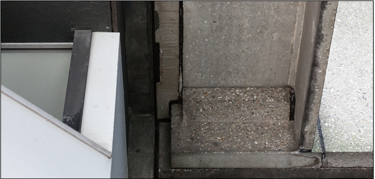
Figuur 7. Vrijwel alle aansluitingen zijn in zeer goede conditie en bevatten weinig tot geen spleten.
