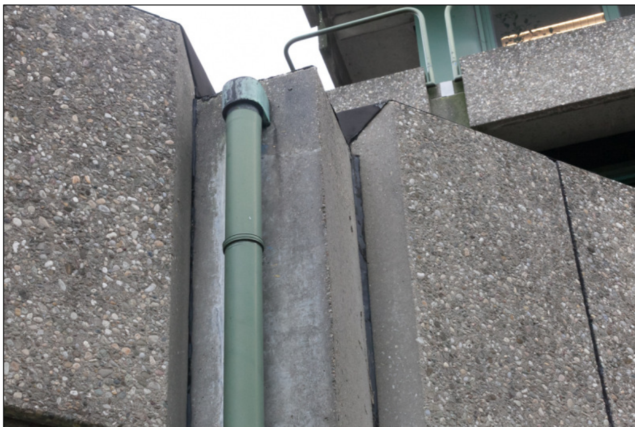
Figuur 6. De dilatatievoegen zijn overal in goede conditie en geven geen ruimte voor dieren.
