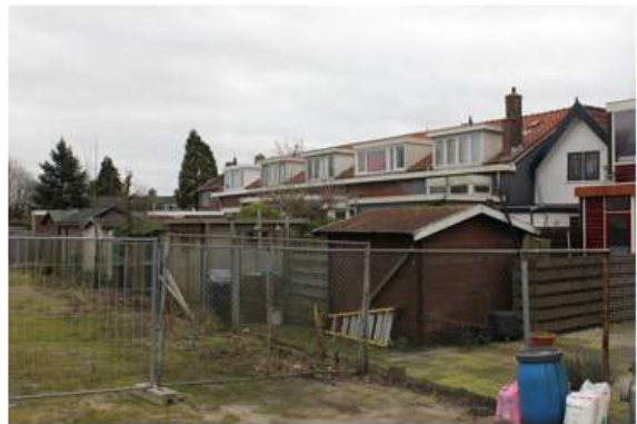
Achterzijde woningen Goudseweg.
