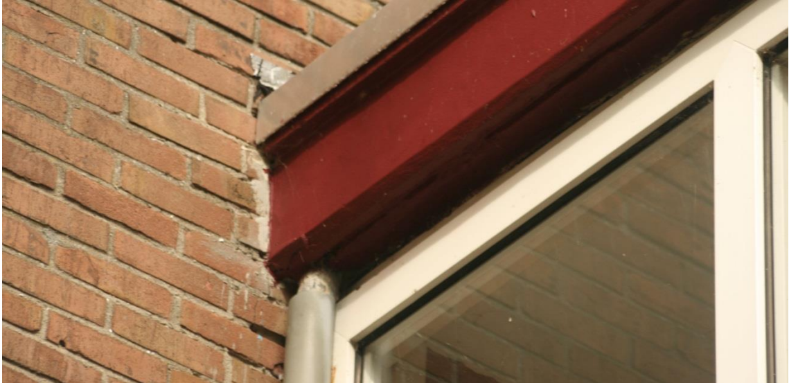
Foto 4, loodflap en leidingdoorvoer
