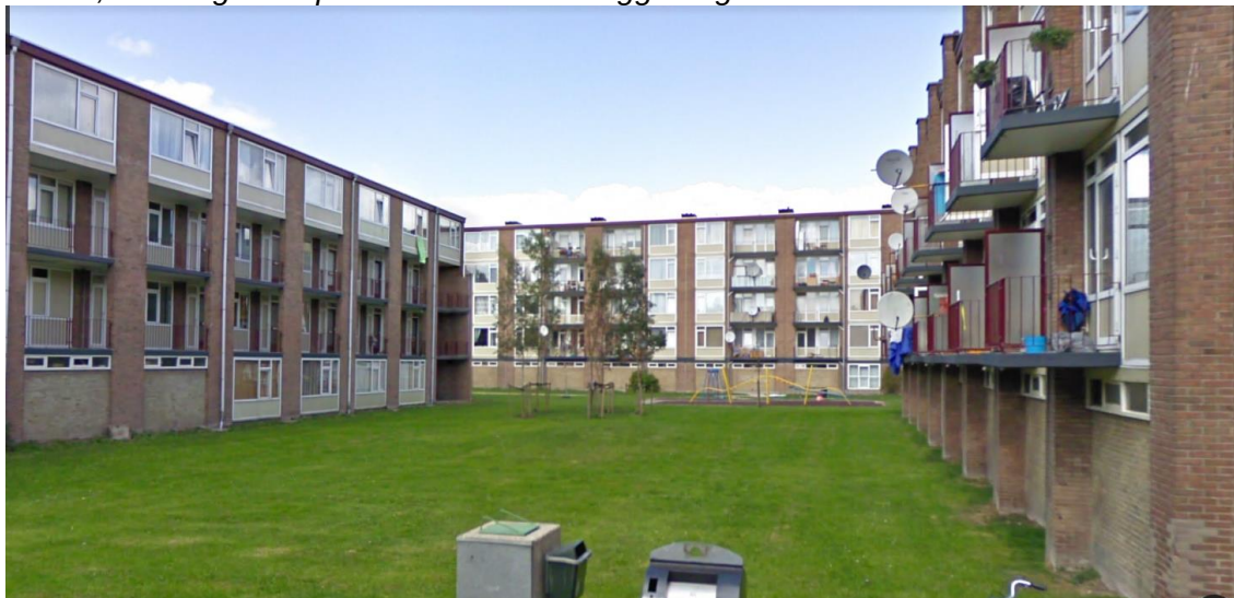
Foto 1, drie nog te slopen flats met tussenliggend gras
