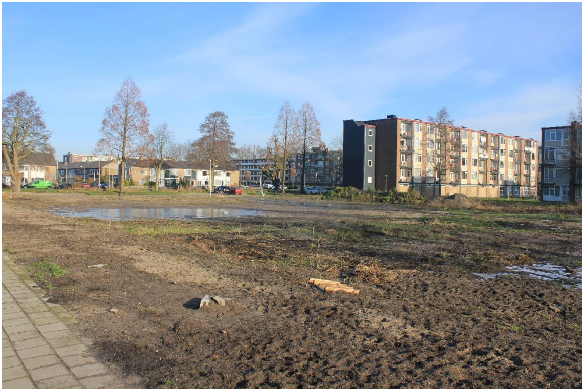
Gedeelte plangebied langs Teldersstraat waar flats al zijn gesloopt.
