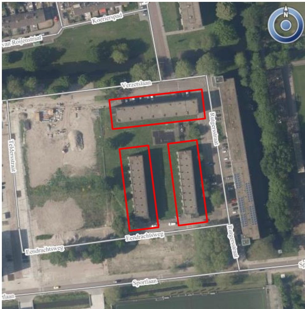
Figuur 1 Luchtfoto van het plangebied (rood omkaderd).
