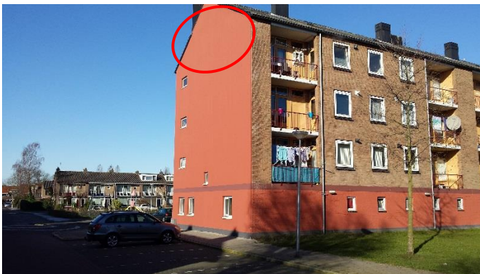
Foto 3. Zuidkant gebouw 3, locatie voor het plaatsen van de vleermuiskasten (rode cirkel).
