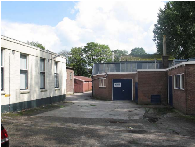
afb. 19: Zicht op het terrein naar het oosten, met links het gebouw van v.h. de Goudsche IJzerwaren- en Gereedschaphandel (Fluwelensingel 86) en rechts Metaalwarenfabriek GMG Melkert (nr. 86a)
