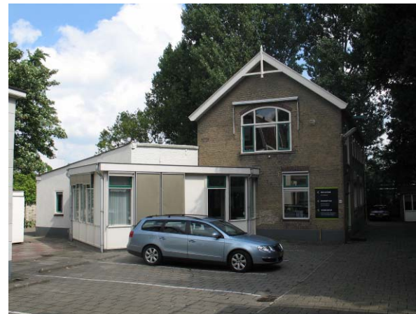
afb. 20: Terrein achter Fluwelensingel 93-94, met het kantoor van Verdouw Bouwproducten, naar het oosten
