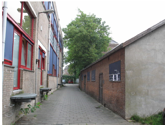
afb. 7: Het straatje Kolfwetering, ten oosten van de Stadswinkel (Klein Amerika 20, links), met rechts een schuur, naar het noorden
