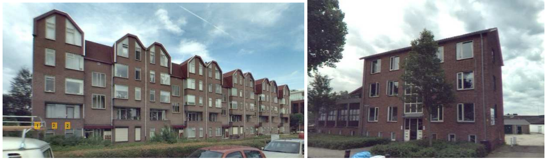
Figuur 22: Woningen aan Nieuwe Gouwe Westzijde (links) en Nijverheidsstraat (rechts) (bron: Cyclomedia)
