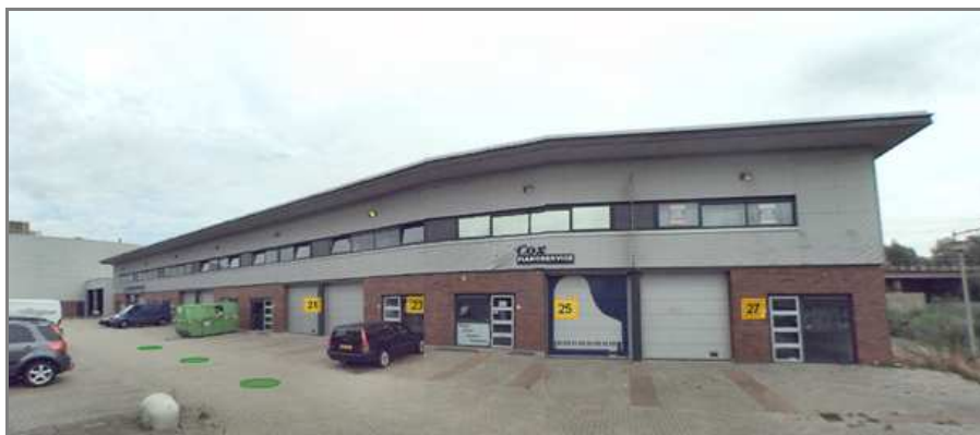
Figuur 20: Bedrijfsverzamelgebouw aan de Keerkring
