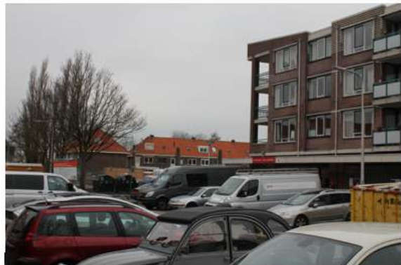
Rechts appartementencomplex Akkerborch met in de plint achter de geparkeerde auto's winkels.
