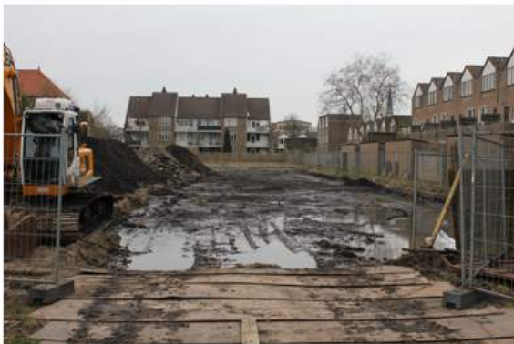
Aanleg parkeerterrein voormalige locatie Futselaar.
