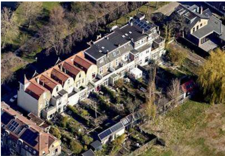
Zicht op de woningen aan de Van Beverninghlaan en hun achtererven
