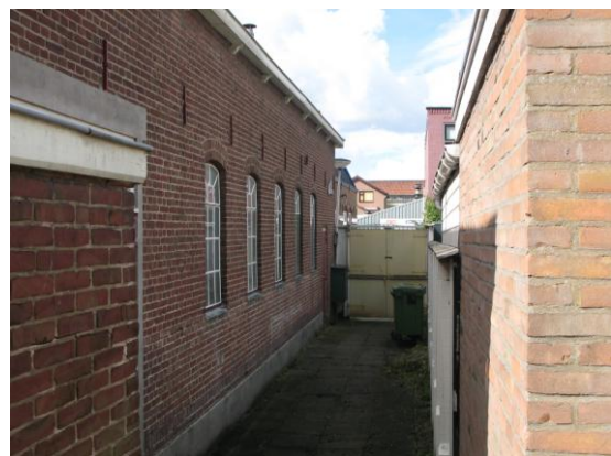
De noordgevel. De kozijnen met metalen roedeverdeling zijn hier zichtbaar.
