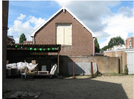
Het bestaande gebouw aan de achterzijde.
