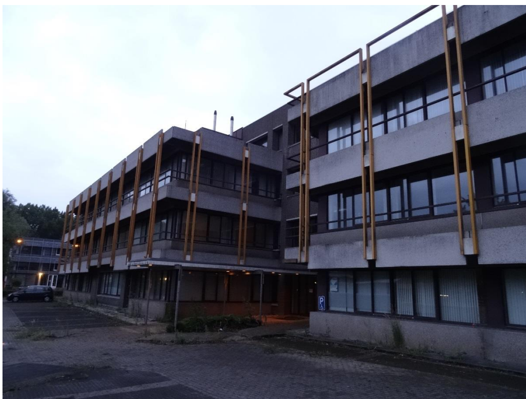
Het te slopen pand aan de Harderwijkweg 1 te Gouda tijdens het ochtendbezoek op 9 juli 2015 (foto's: Laneco)
