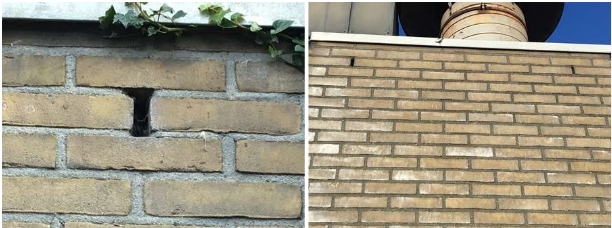
Potentiële invliegopeningen van vleermuizen om een verblijfplaats te bezetten in de spouw. Foto links: buitengevel van een woning Foto rechts: buitengevel van het bedrijfsgebouw.
