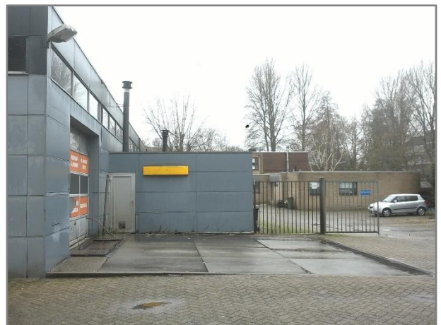
Foto 12: Uitgang wasplaats en buitenzijde spuitcabine (uitbouw)
