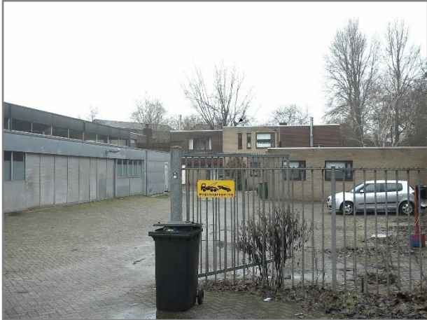
Foto 18: Westzijde onderzoekslocatie, inrit richting woningen
