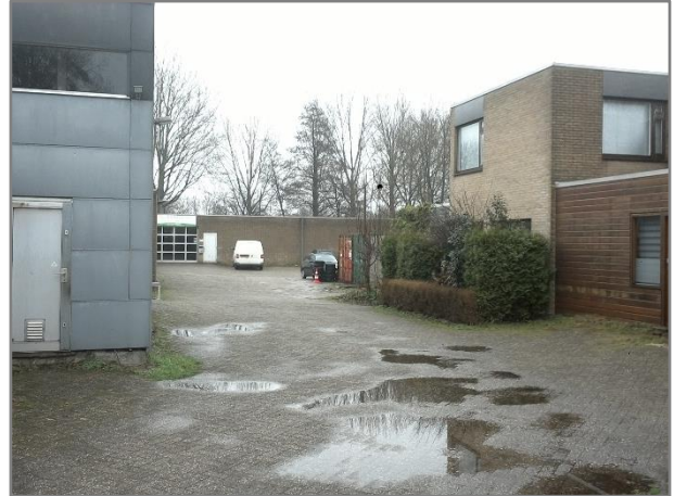
Foto 17: Achterterrein met rechts woningen
