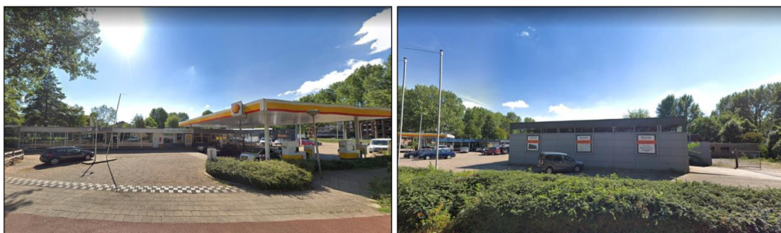
Afbeelding 2.3 Luchtfoto en straatbeelden projectgebied (Bron: Google streetview)
