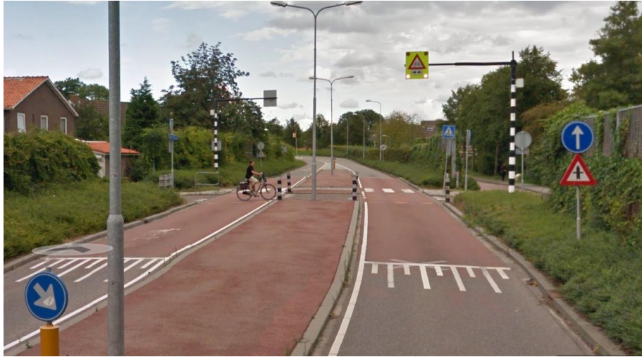
Fietsoversteekplaats met attentie-verhogende maatregelen (waarschuwingslichten)
