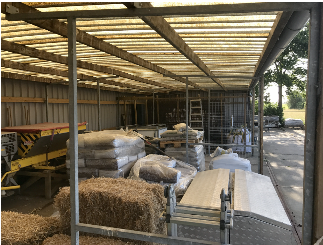
Afbeelding 2: Bestaande open stalling in het plangebied. Foto: L. Boon, Ecoresult B.V.
