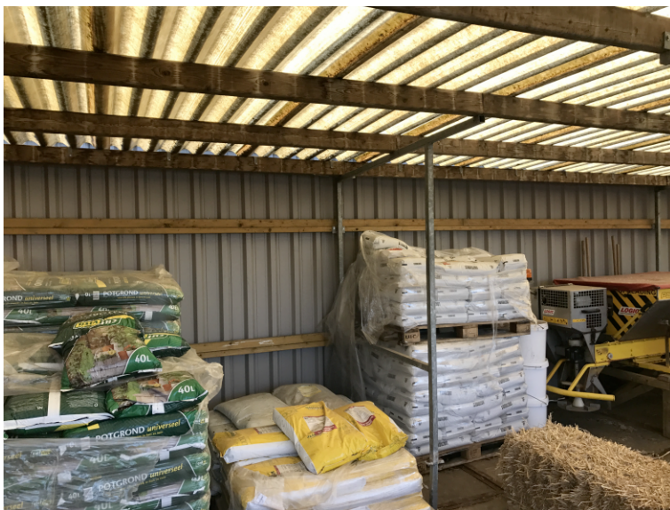
Interieur te slopen opstal. Fotograaf: L. Boon, Ecoresult B.V.
