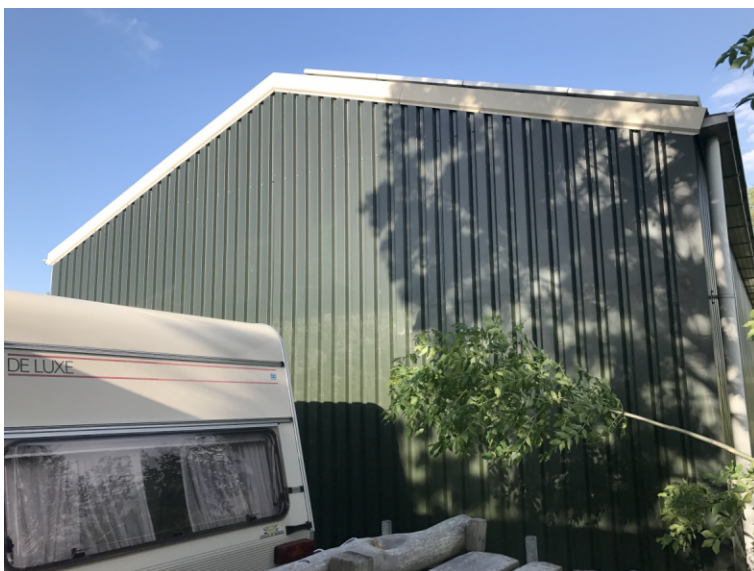
Aan deze gevel van de loods grenzend aan het plangebied wordt de nieuwbouw aangebouwd in het plangebied. Fotograaf: L. Boon, Ecoresult B.V.
