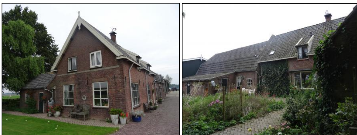
Figuur 6: De te slopen bedrijfswoning
