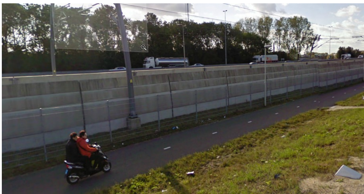
Figuur 6.2.1: fietspad naast HSL
