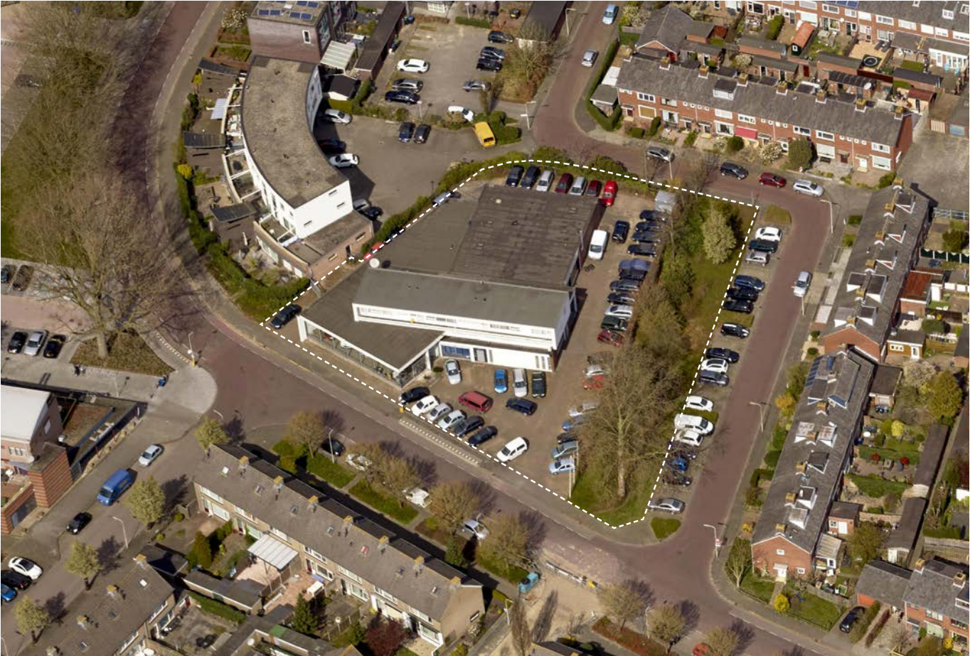
Figuur 2.2: Foto-impressies van de bestaande situatie met het garagebedrijf
