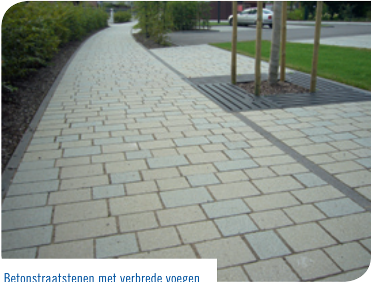
Betonstraatstenen met verbrede voegen
