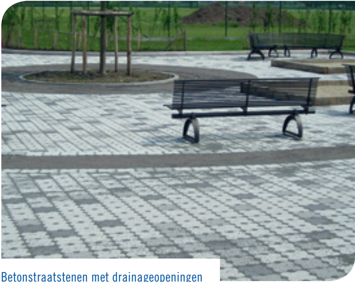
Betonstraatstenen met drainageopeningen
