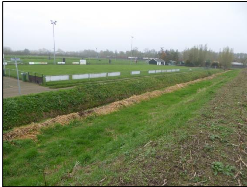
De verhoging is hier te zien met daarachter de watergang;
