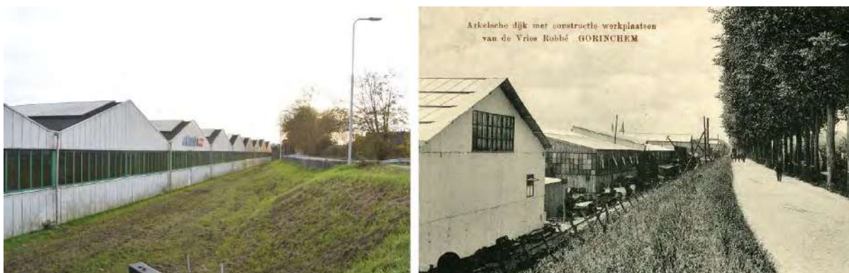
Figuur 52. Exterieur van gebouw 9 met links de huidige situatie van de loodsen met zadeldak bij de Arkelsedijk. Rechts een historische foto gemaakt tussen 1914 en 1928 met de zuidelijkste loods van de vier in 1914 gebouwde loodsen (RAG). De gebouwen daarachter zullen later gesloopt worden voor de loodsen van gebouw 9 uit 1928 en 1929 en gebouw 13 uit 1947.
