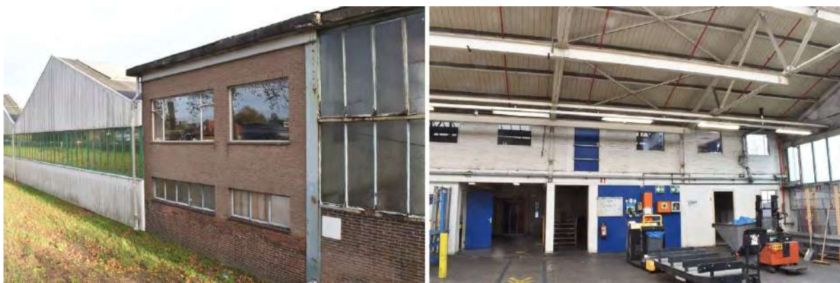
Figuur 47. Overzicht van gebouw 9a. Links het exterieur van het kantoor gezien vanaf de dijk en rechts het exterieur gezien vanuit loods 9b met kantoorfunctie op de verdieping.
