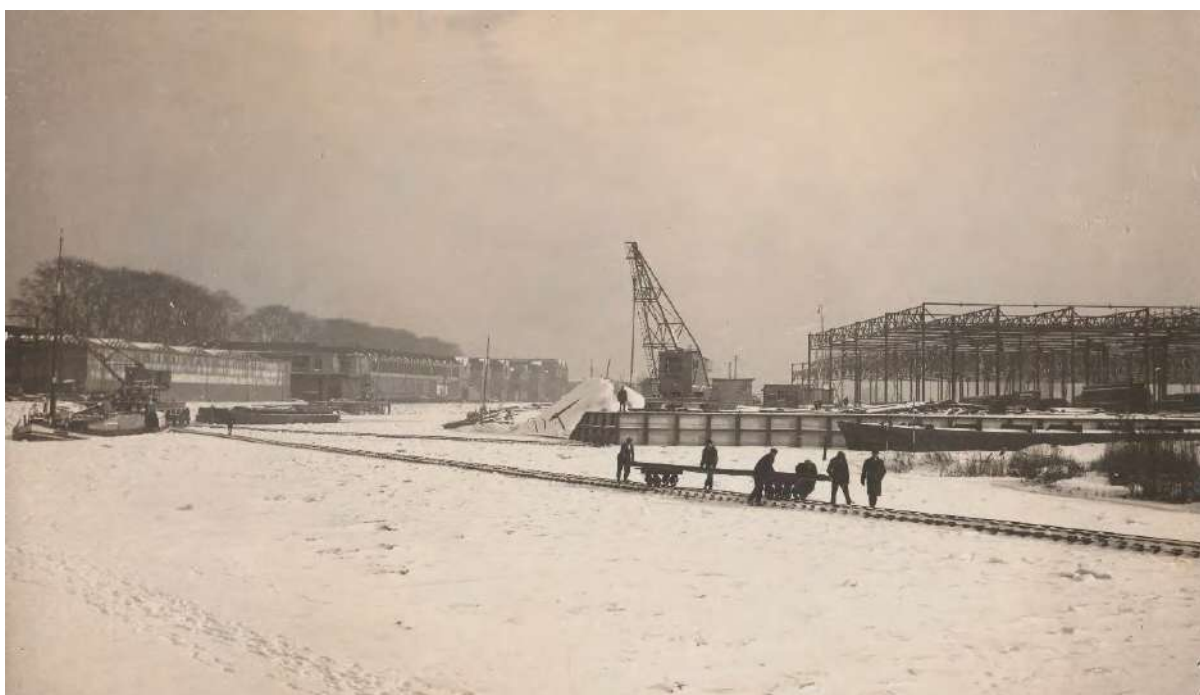
Figuur 18. Bouw van een nieuwe fabrieksloods aan de overkant van de Linge in 1928 . Dit is het begin van Fabriek II (Regionaal Archief Gorinchem).
