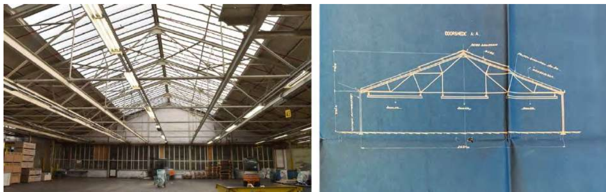
Figuur 51. Gebouw 9e uit 1928. Links een foto met het interieur van de loods met een overspanning van meer dan 25 meter en rechts een detail van de bouwtekening met de constructie met drie traverses. (RAG Bouwvergunningen).
