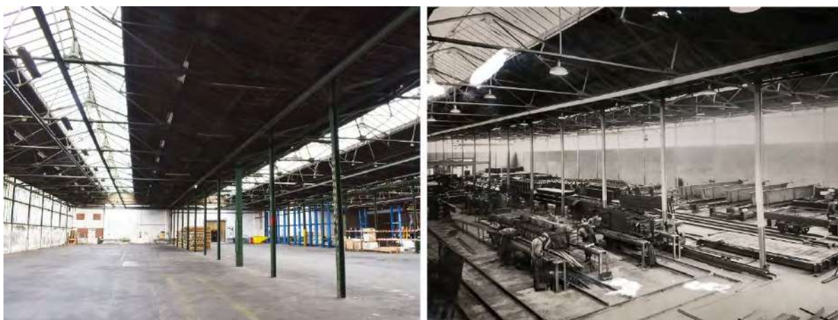
Figuur 42. Gebouw 7 met links de huidige situatie en rechts de loods in gebruik om te lassen in de jaren 50 (Regionaal Archief Gorinchem).
