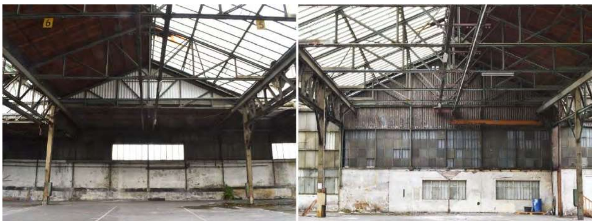
Figuur 34. Overzicht van gebouw 2c met Engelse spanten. Links gezien naar de Arkelsedijk toe en rechts gezien naar de Linge.
