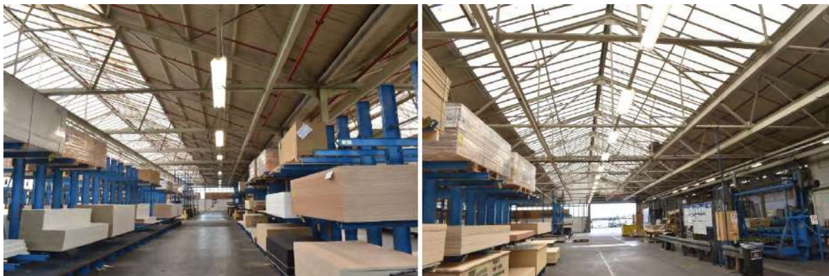
Figuur 48. Overzicht van de twee loodsen van gebouw 9b uit 1928 en 1929. Rechts de meest zuidelijke loods tegen het kantoor aan en links de loods die daar ten noorden van ligt.
