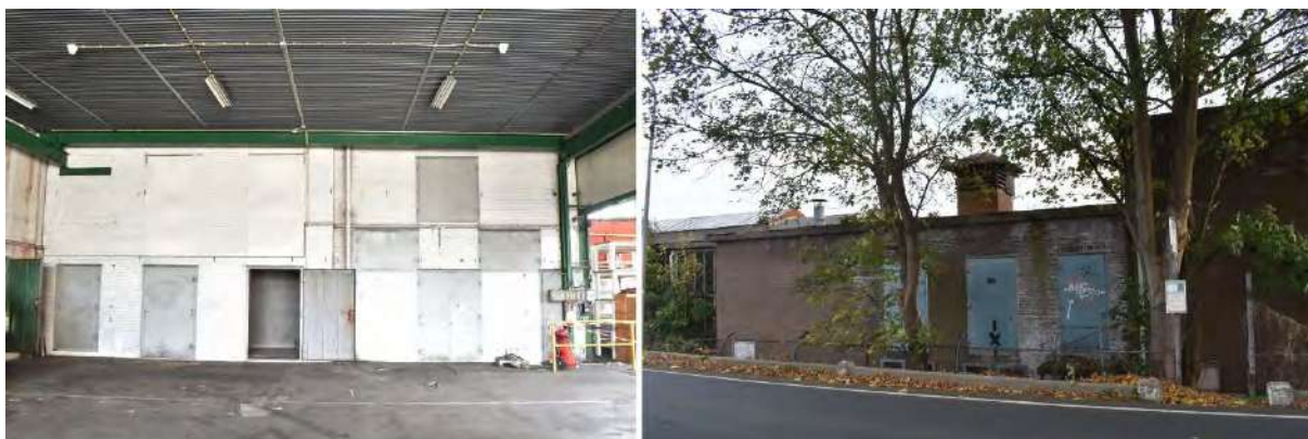
Figuur 39. Gebouw 5 met het exterieur links gezien vanuit gebouw 6 en rechts gezien vanaf de dijk.
