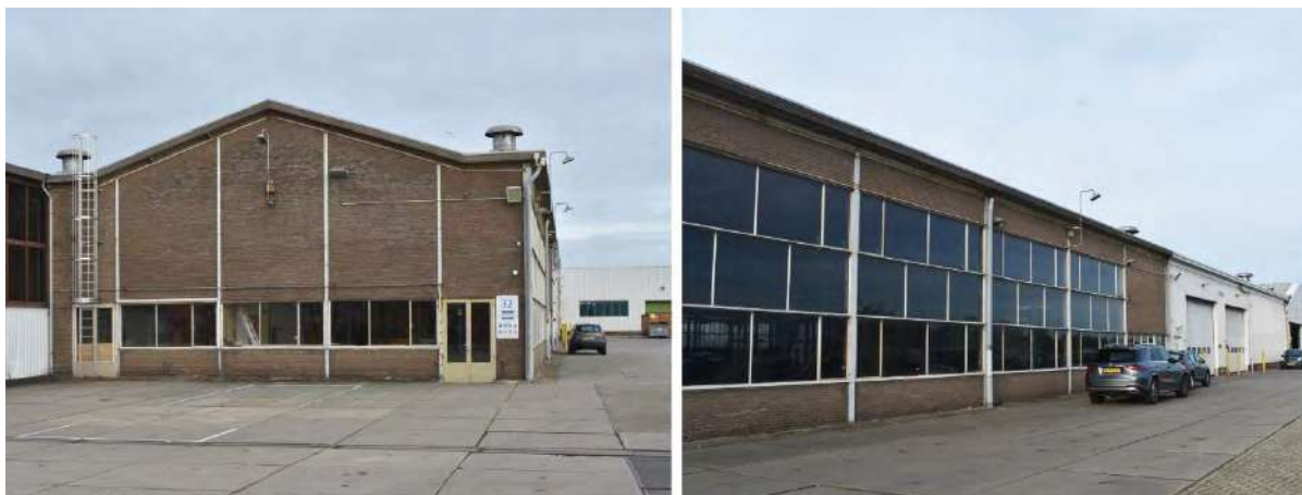
Figuur 44. Overzicht van het exterieur van gebouw 8 met links de kopse kant en rechts de zijgevel met verschuivende stalen vensters.
