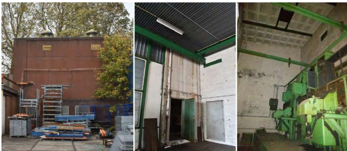
Figuur 38. Gebouw 4. Links het exterieur vanaf het terrein aan de Linge. In het midden de ingang aan de noordzijde die zich nu in pandig in gebouw 6 bevindt en rechts het interieur van Trafo I met op de eerste verdieping een wand met verdeelkasten.
