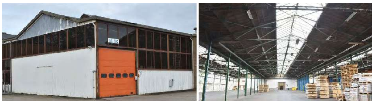
Figuur 41. Overzicht van gebouw 7 met links het exterieur en rechts het interieur van de oostelijke loods met Polonceau spanten en lichtstraat.
