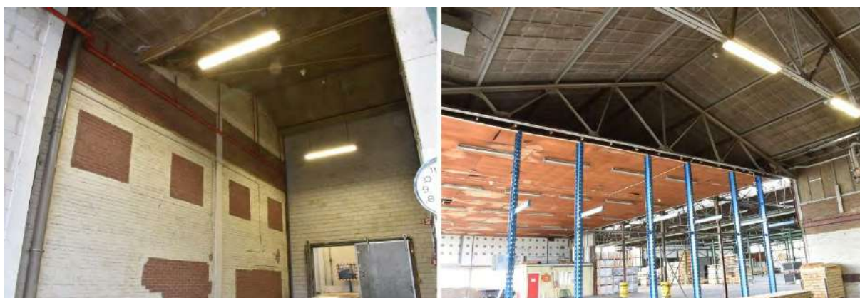
Figuur 45. Overzicht van het interieur van gebouw 8 met links het meest noordelijke deel met de dichtgezette vensters van het voormalige kantoor van gebouw 9 en rechts de overgang van de loods (8b) naar de nieuw kantine uit 1964 (8a).
