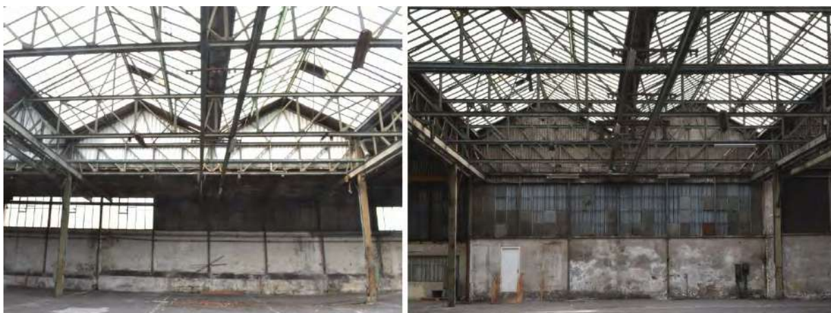
Figuur 33. Overzicht van gebouw 2b. Links gezien naar de Arkelsedijk toe en rechts gezien naar de Linge.
