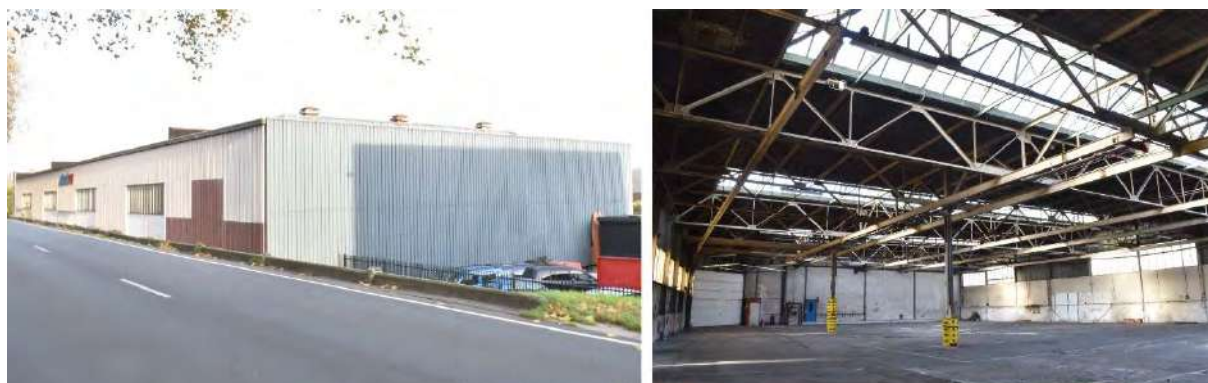
Figuur 28. Gebouw 1 met links het exterieur en rechts het interieur van het middelste gedeelte.
