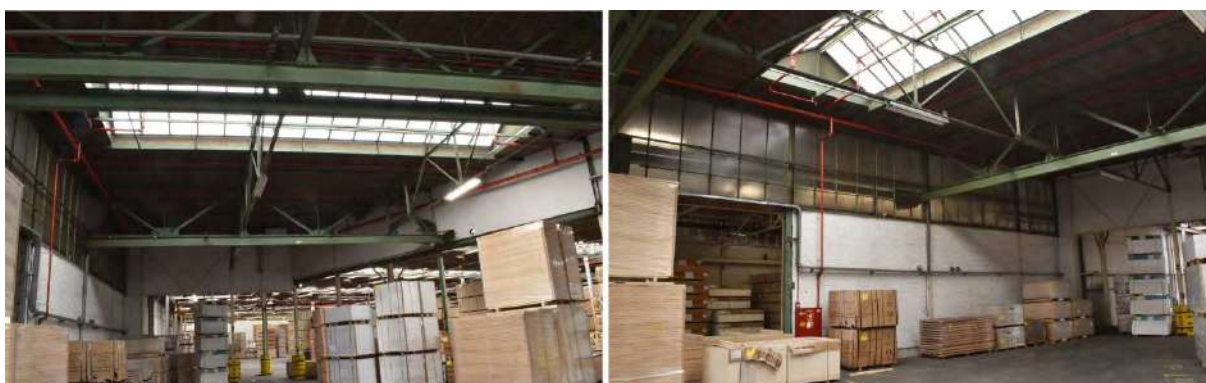
Figuur 56. Gebouw 12 met het interieur links gezien richting de aansluiting met gebouw 13. Rechts zicht vanuit gebouw 12 met de ramen in de zijgevel van gebouw 11.
