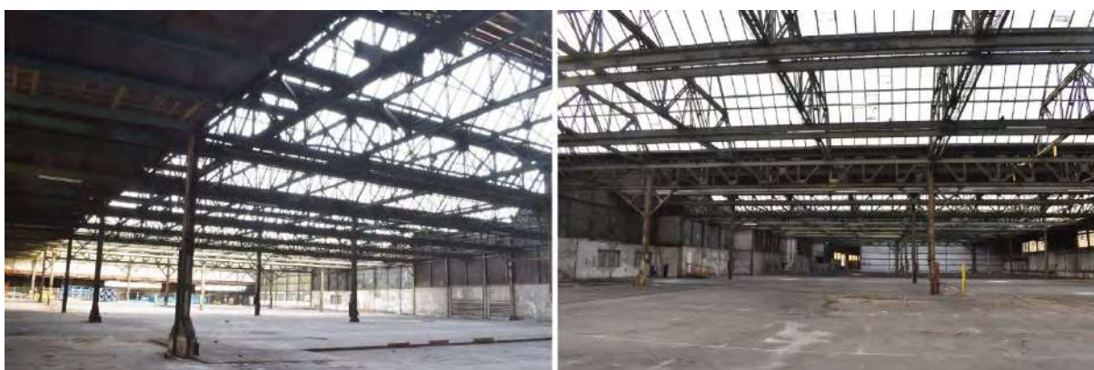
Figuur 30. Overzicht van het interieur van gebouw 2 met links gezien uit het zuidwesten en rechts gezien uit het noorden.
