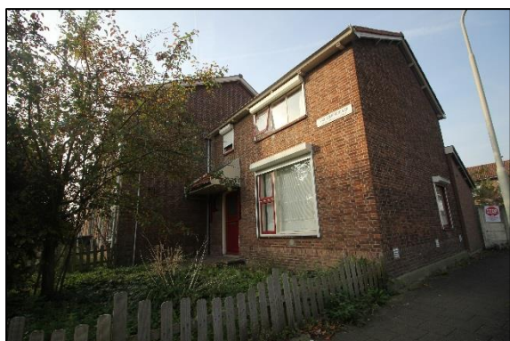
Foto 1: Te slopen woningen van Zomerendaan
