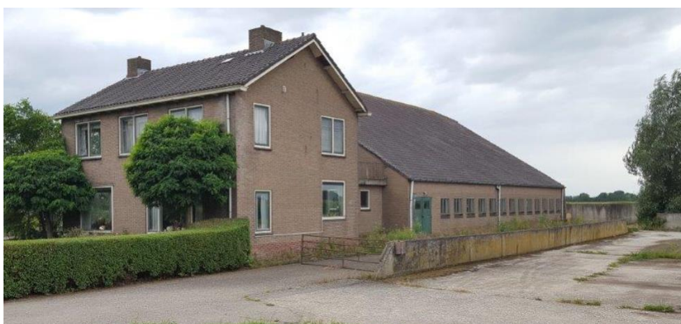
Afbeelding 6: Aanzicht perceel Vlietskade 80-82 Gorinchem
