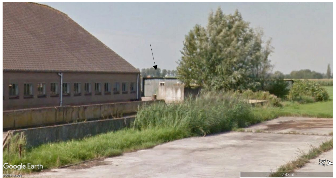
gesloopte houten schuur achterzijde
